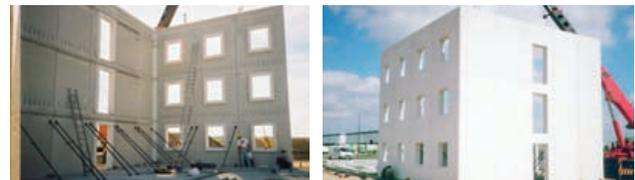
Figura 3: Estructura con pared portante para un hotel. Fuente: Prainsa.
