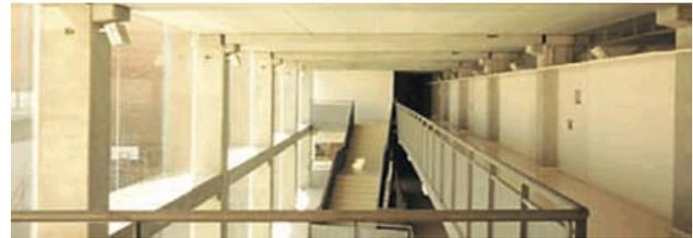
Figura 1: Edificio de oficinas realizado con forjados de placas alveolares y vigas Twin. Fuente: Hormipresa
