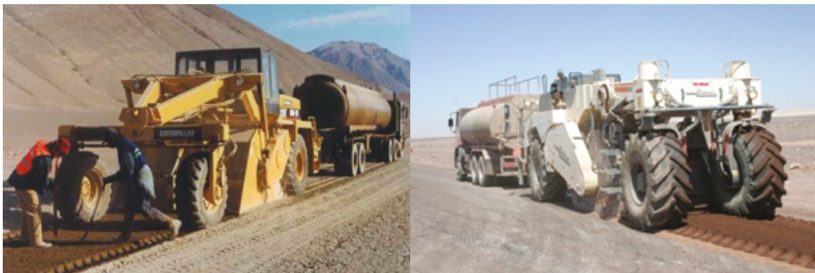
Fotos N° 10 y 11. Empleo de Recuperadora y Recicladora para aplicar bischofita (contenida en el aljibe conectado)
