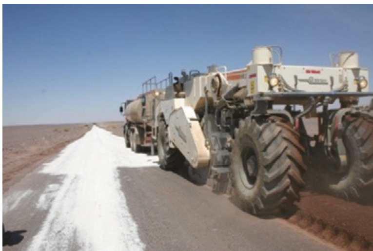
Foto N° 5. Empleo de Recicladora para incorporación de sal a carpeta existente
