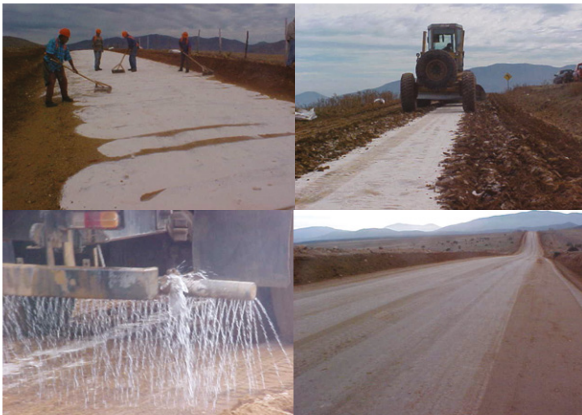
Fotos N° 1 a N° 4. Esparcido de sal, homogeneización, adición de agua de compactación y resultado final de una carpeta con cloruro de sodio
