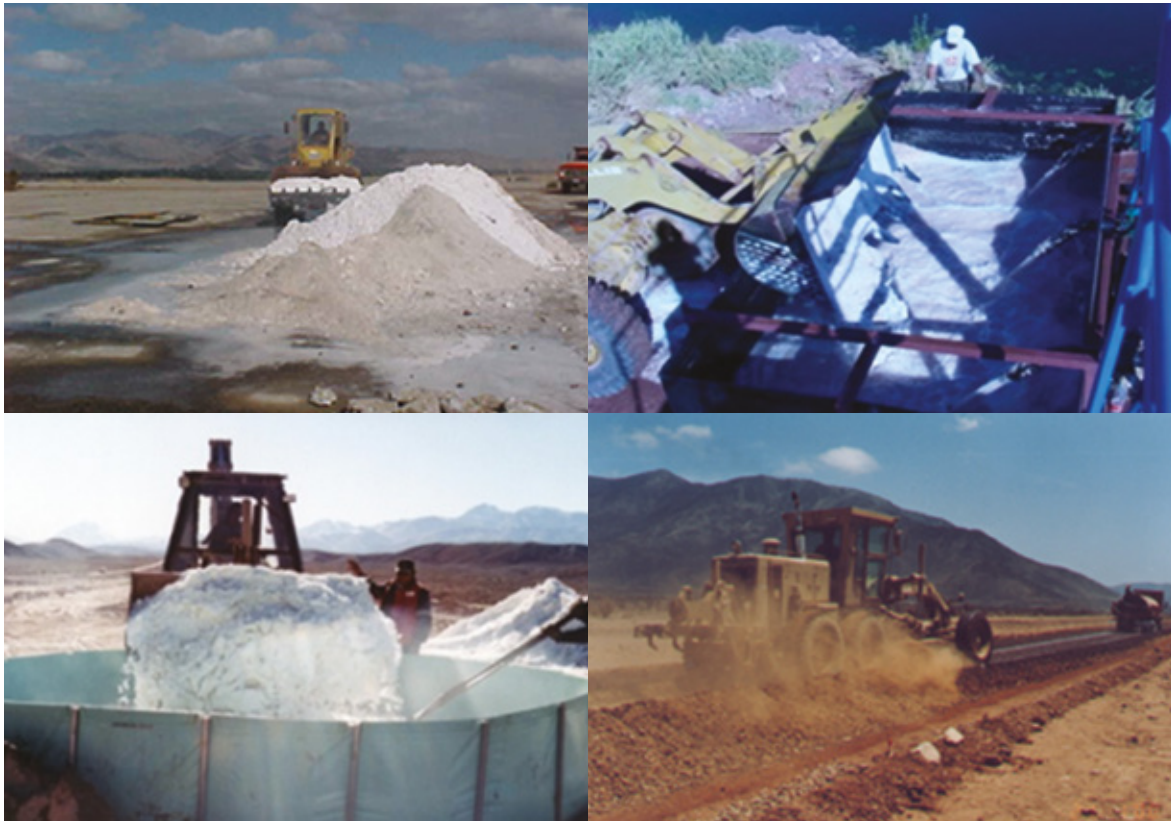
Fotos N° 6 a 9. Carguío de la bischofita, vaciado a estanques, riego y homogeneización de la salmuera en la carpeta
