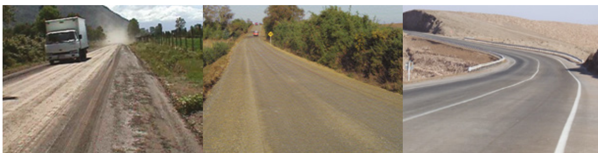
Fotos N° 13 a 15. Resultados de Caminos con cloruro de sodio.
