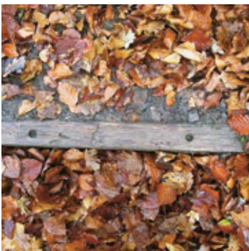
Fig. 56 Marche avec percements pour les fers d'armature
