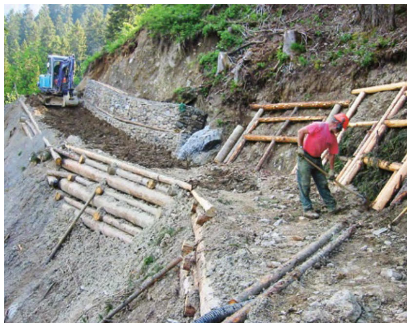
Fig. 81 Stabilisation d'un talus avec des caissons en bois (à gauche), des gabions (au fond) et un treillage (à droite).
