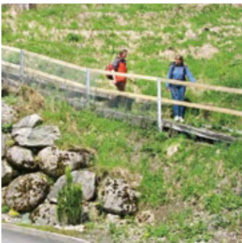
Fig. 62 Balustrade en bois
