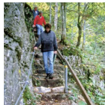
Fig. 64 Les mains courantes donnent un sentiment de sécurité
