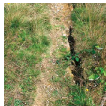
Fig. 5 Fissures du sol
