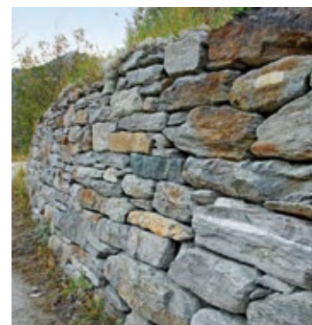
Fig. 82 Mur en pierres sèches
