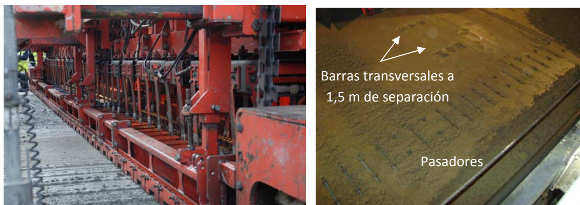
Figura 8.11.- Instalación de pasadores: a) equipo de instalación y b) pasadores instalados
