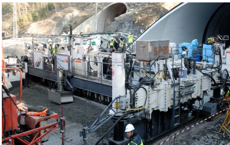
Figura 3.4.- Extendedora de la capa de rodadura
