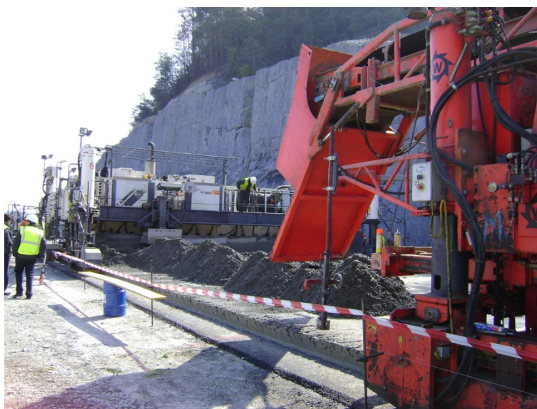
Figura 3.26.- Excesiva distancia entre las dos extendedoras
