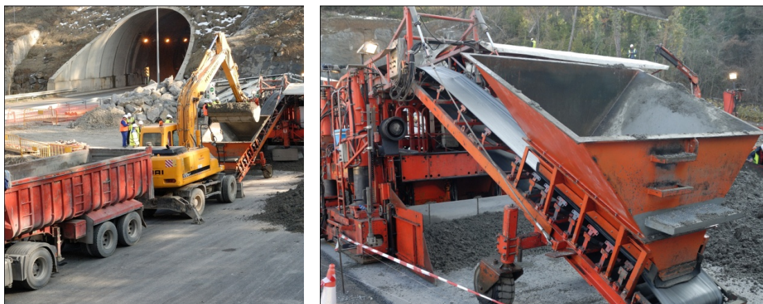
Figura 3.1.- Vertido del hormigón capa rodadura: a) Pala intermedia, b) tolva receptora
