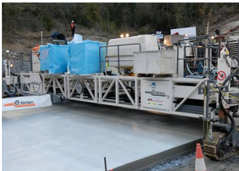
Figura 3.5.- Parte posterior del tren de pavimentación correspondiente al carro de curado
