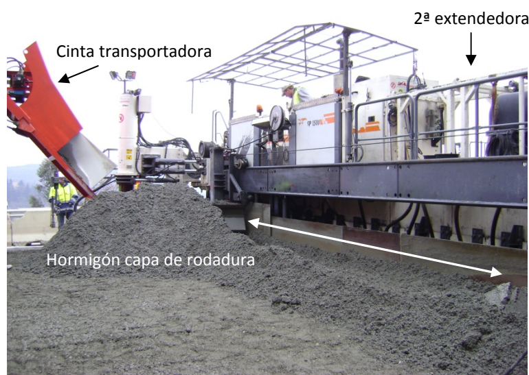
Figura 3.18.- Frente de avance de la 2ª extendedora y hormigón de la capa de rodadura
