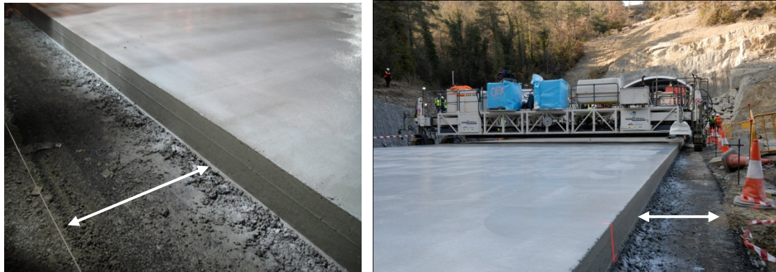
Figura 3.11.- Sobreancho de la capa asfáltica para zona de rodadura de los equipos
