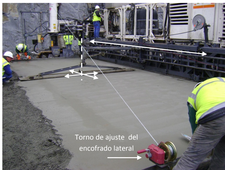
Figura 3.20.- Fratasado del hormigón de la capa de rodadura
