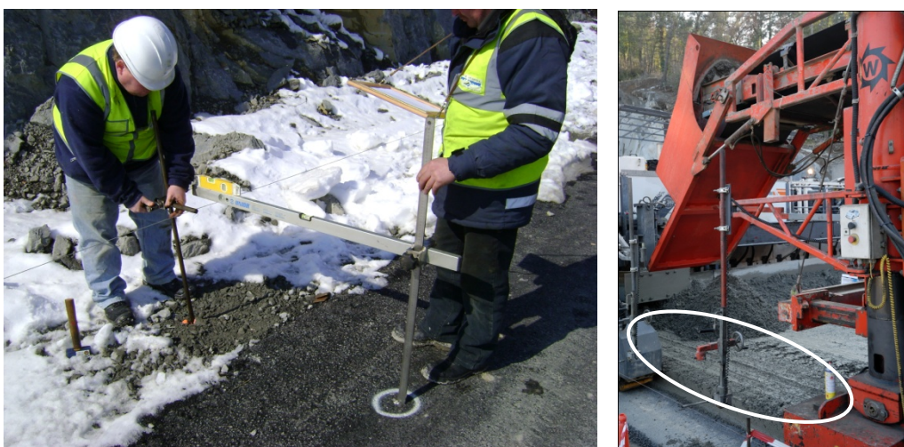
Figura 3.12.- Sistema de guiado: a) Ubicación de estacas y b) sistema de guiado
