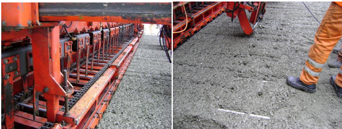
Figura 3.15.- Barras longitudinales: a) Colocación y b) aspecto del hormigón
