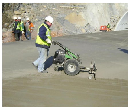
Figura 3.7.- Eliminación de finos con el empleo de una minihoja autopropulsada
