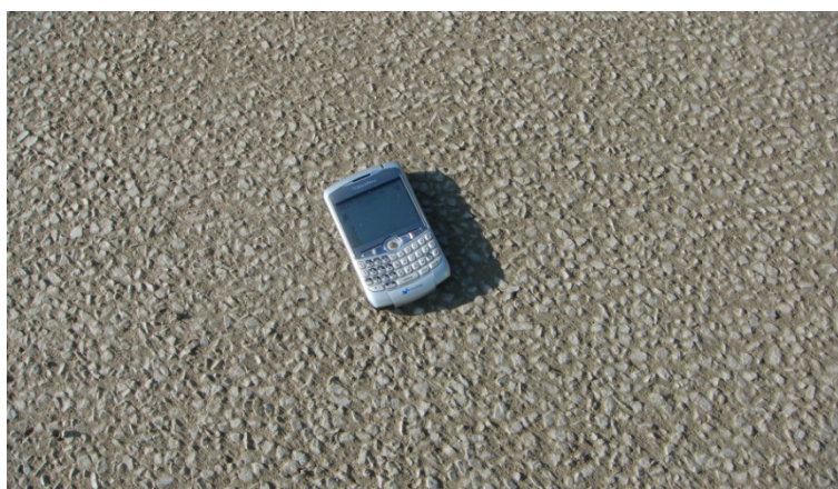
Figura 3.27.- Acabado de la capa de rodadura
