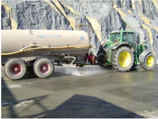
Figura 8.7.- Limpieza base bituminosa
