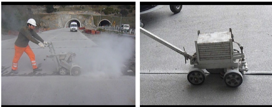
Figura 3.10.- Equipos finalización de juntas: a) Cajeados y b) Introducción perfiles elastoméricos
