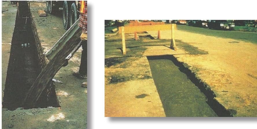
Figura 6. Relleno de una zanja con MBRC mediante vertido directo desde camión. A la derecha se aprecia el MBRC alcanzando la cota inferior
