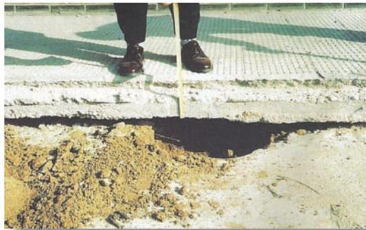
Figura 1b. Socavón bajo la acera provocado por una ejecución inadecuada de los rellenos de las zanjas
