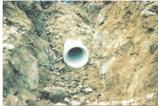
Figura 3. Relleno de una zanja con material sin seleccionar
