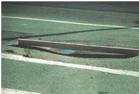
Figura 5. Bache en la calzada originado por un relleno incorrecto
