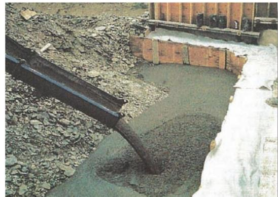
Figura 12. Relleno de un trasdós de estribo
