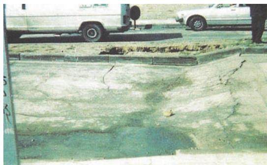
Figura 1a. Hundimiento de calzada y acera provocados por una ejecución inadecuada de los rellenos de las zanjas
