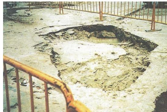
Figura 4. Socavón en la calzada
