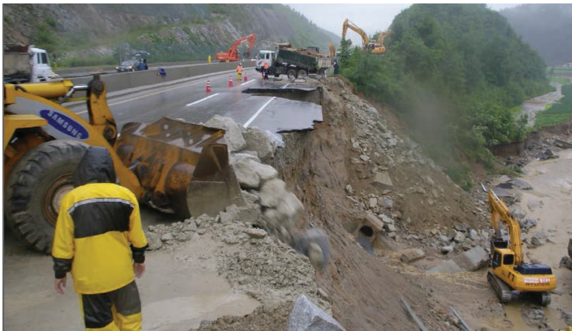
Eboulement sur une autoroute en République de Corée, suite à des pluies torrentielles
