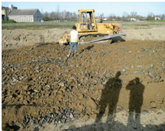
Valorisation de pneus usagés en remblai : 50 % copeaux de pneus et 50 % de sablines
