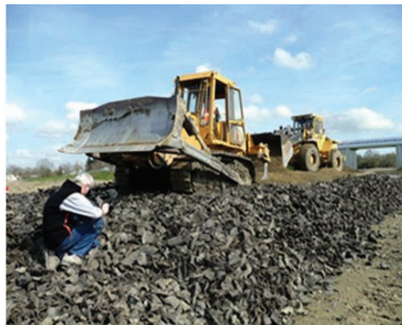
Valorisation de pneus usagés en remblai : 50 % copeaux de pneus et 50 % de sablines
