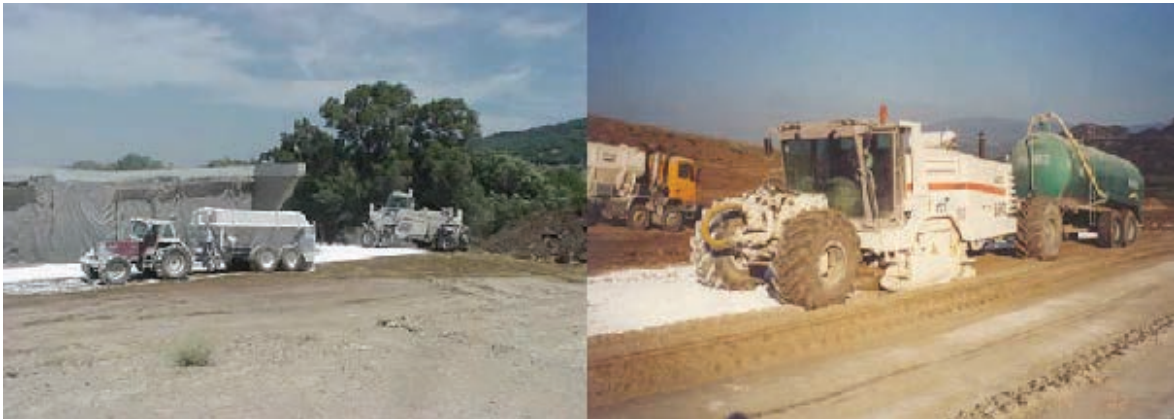
Atelier de traitement à la chaux (Espagne)
