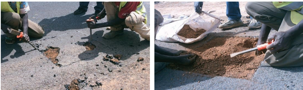
Prélèvement de matériaux latéritiques sous chaussées anciennes (tronçons Mboro – Diogo et Darou Marnane – Mbacké Cadior)
