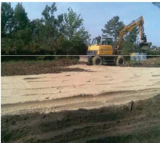
Préparation du mélange sur la zone de dépôt provisoire (1000m 2 )
