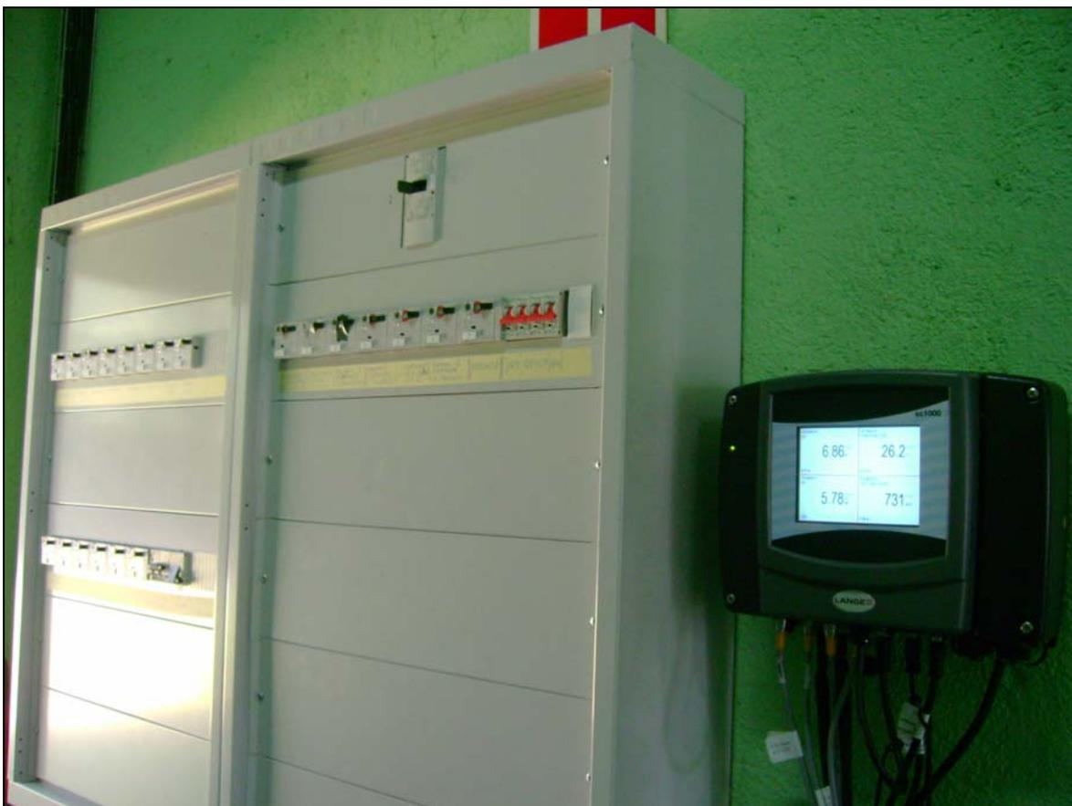
Figura 83: Panel de control y controlador SC 1000 con pantalla táctil
