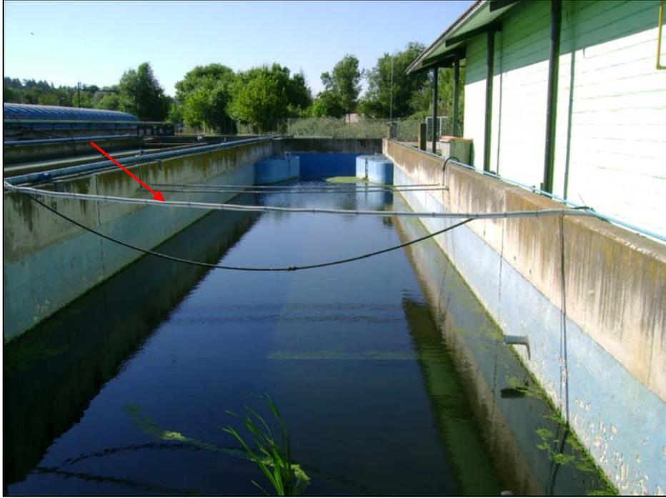
*Figura 78: Manguera que conduce el agua hasta la planta piloto*
