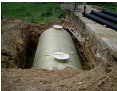
Fosa séptica prefabricada
