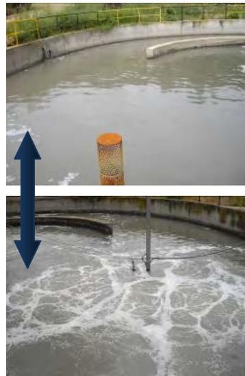
Zonas sin y con funcionamiento de soplantes en el reactor
