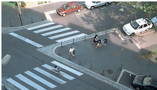
BEV implantées dans un carrefour à voies obliques avec passages piétons en alignement avec la voie.
