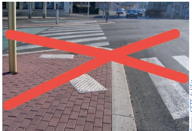
Mauvaise implantation de BEV.
