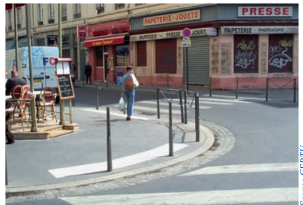
Exemple de BEV implantées sur trottoir abaissé en arrondi, sauf en présence des barrières.
