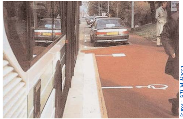
Marquage des positions de porte avant et centrale au point d'arrêt.
