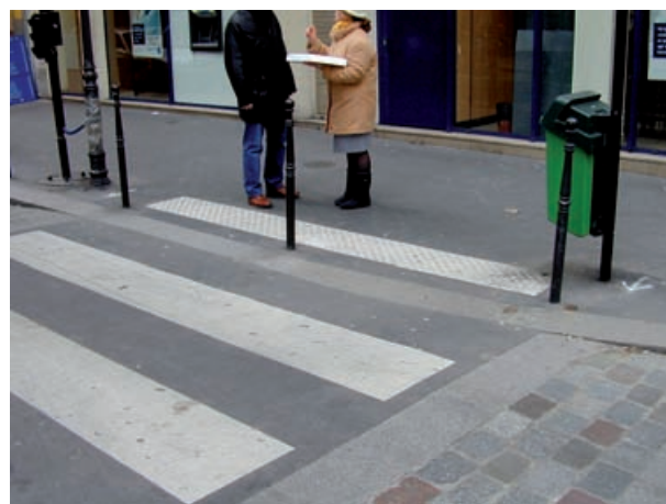
BEV implantée au droit d'une traversée avec chaussée surélevée.
