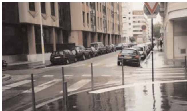
BEV implantées dans un carrefour à voies perpendiculaires et traversées dans les arrondis, : difficulté d'orientation.
