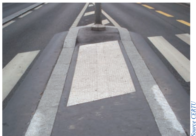
BEV implantée sur îlot-refuge de 1,80 à 2,30 m.
