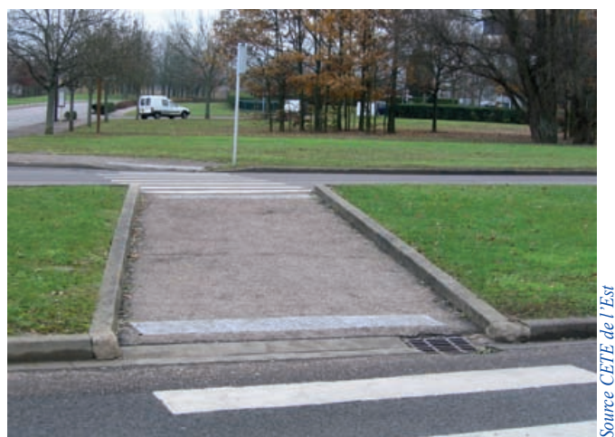
BEV implantée sur îlot de plus de 2,70 m.
