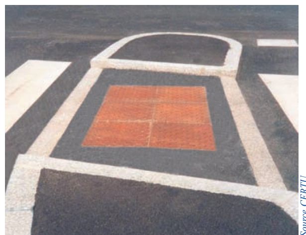
BEV implantée sur îlot-refuge avec traversée en 2 temps, largeur comprise entre 1,50 et 1,80 m
