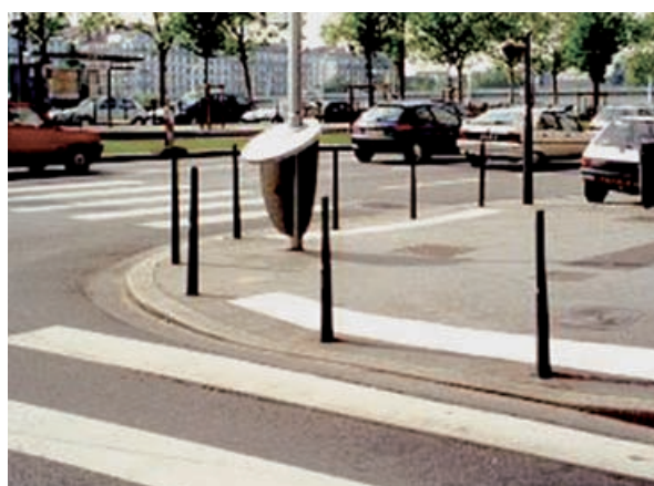
Abaissés de trottoir sur l'arrondi avec bordure centrale relevée.
