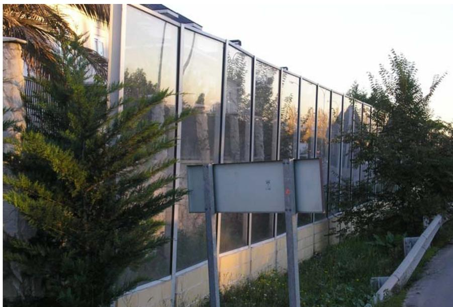
Fotografía 10.4 Detalle de la pantalla antirruído colocada en San Fernando de Henares
