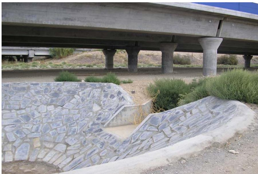
**Fotografía 8.2 Balsa de decantación en la R-4. Viaducto del río Tajo, km 31.**
