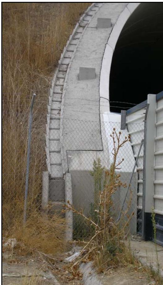
**Fotografía 10.21** Detalle de conexión entre la pantalla antirruído y el falso túnel en el bypass
