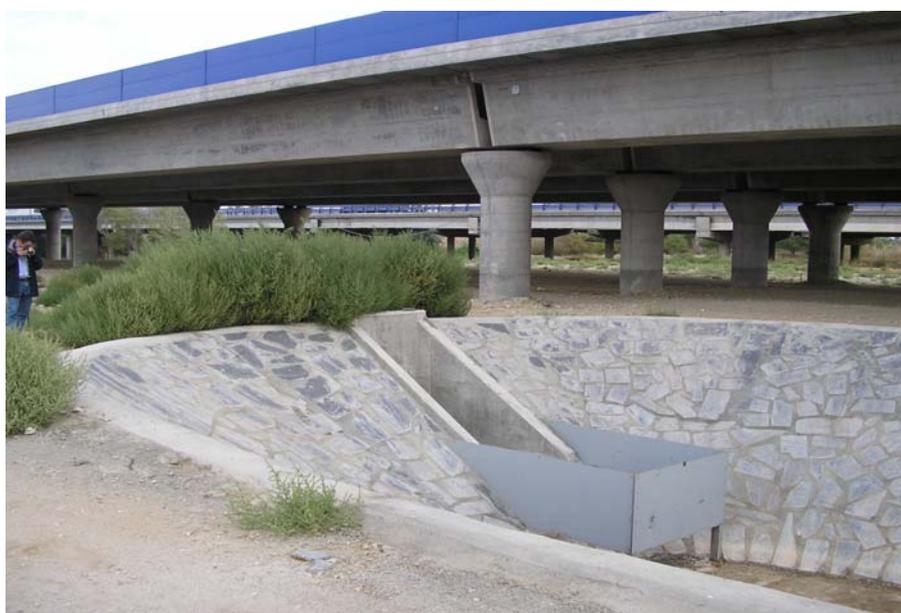
**Fotografía 8.3 Balsa de decantación en la R-4. Viaducto del río Tajo, km 31**
