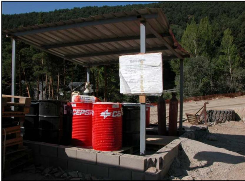
Fotografía 9.14 Instalación de punto limpio en obra
