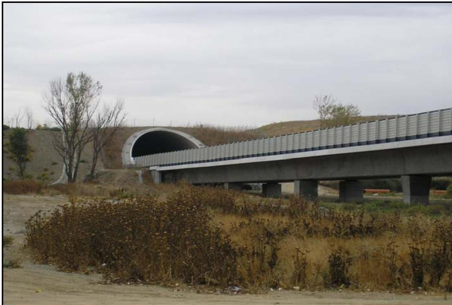
**Fotografía 10.20 Bypass en el viaducto del río Manzanares. Conexión de la pantalla antirruido (reflectante) con el falso túnel**
