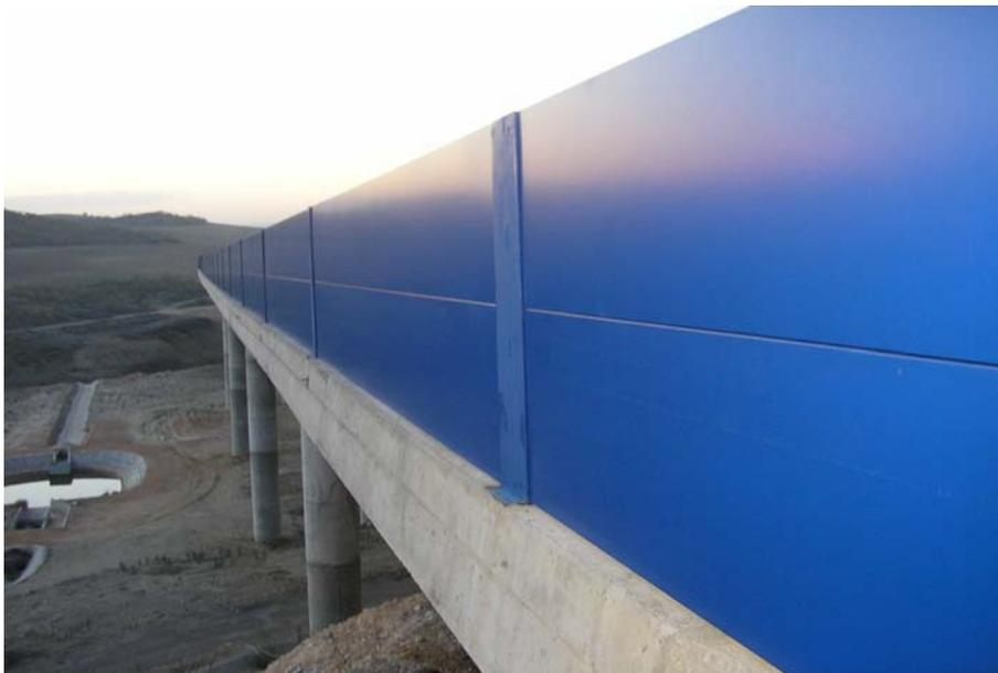
Fotografía 10.2 Pantalla antirruído colocada en la R-4
