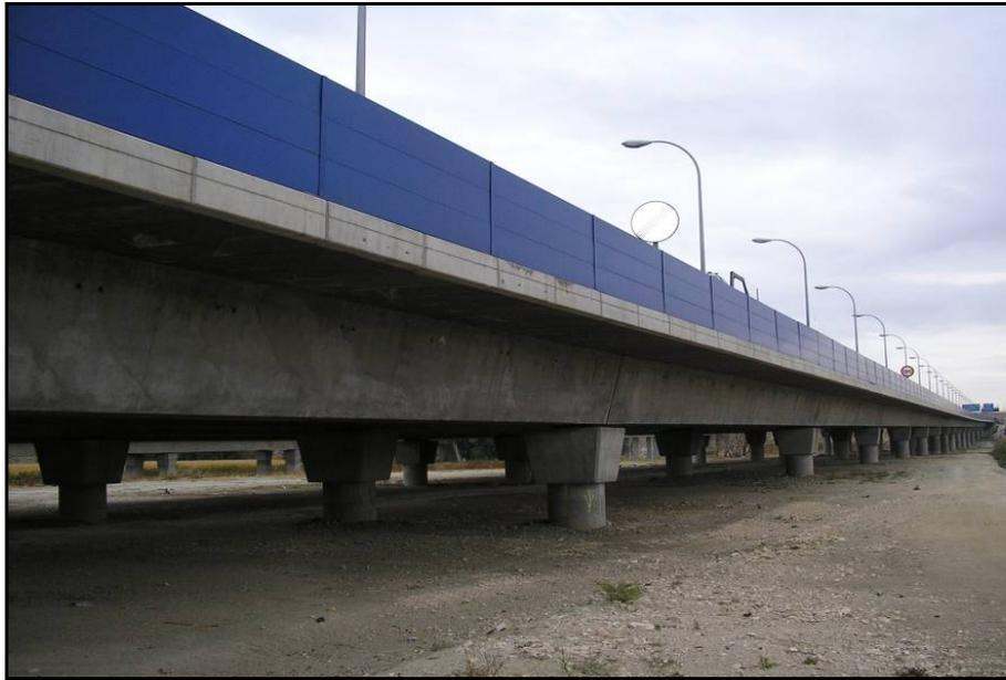
Fotografía 10.15 Pantalla antirruído en la M-50, conectada al falso túnel de Perales del Río
