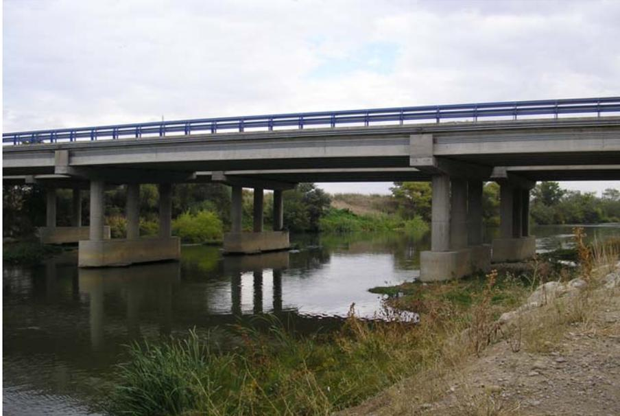
Fotografía 8.7 Pilas dentro del cauce de la A-4.
