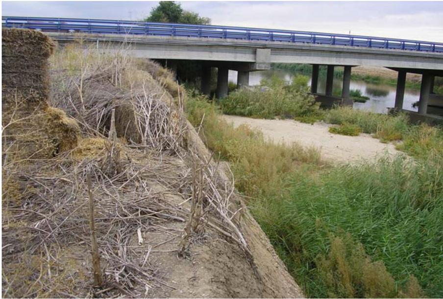
**Fotografía 8.6** Balas de paja para retención de sedimentos y evitar la afección al cauce
