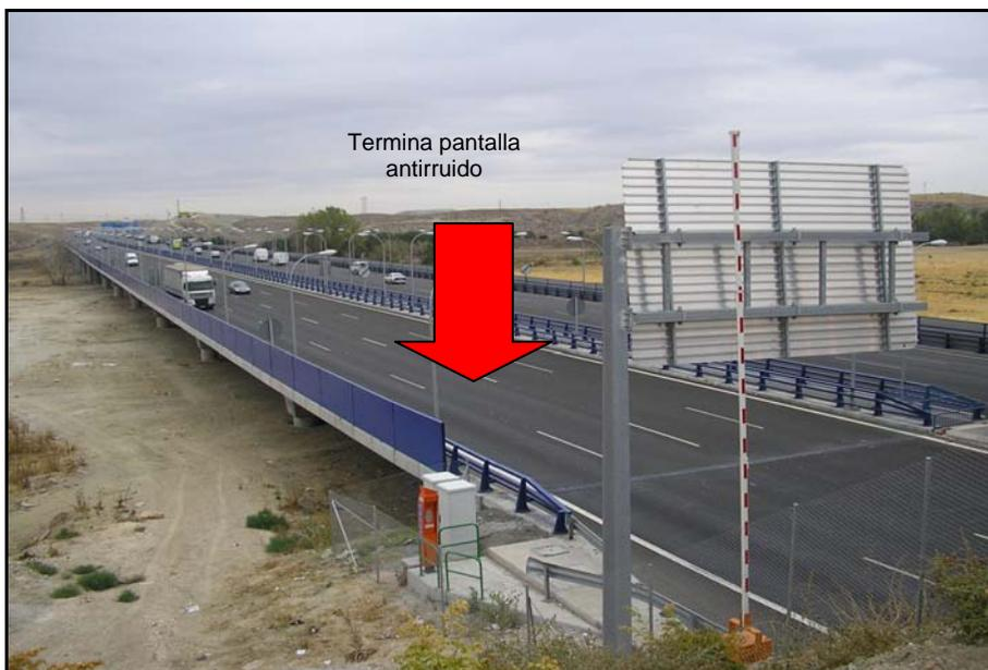
Fotografía 10.18 Conexión de la pantalla a la entrada del falso túnel de Perales del Río
