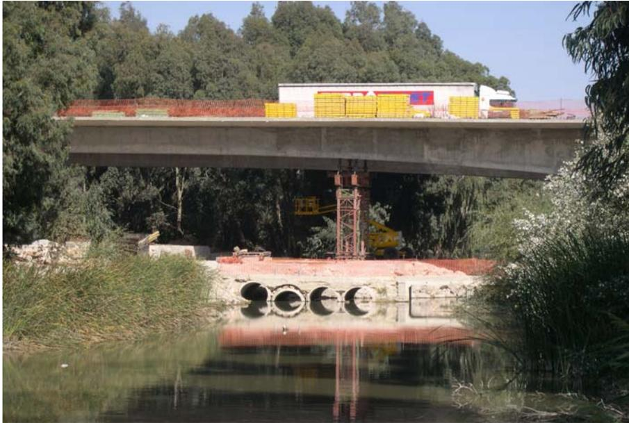
**Fotografía 8.12** Desviación del río durante las obras de construcción del tramo 0 de la A-381
