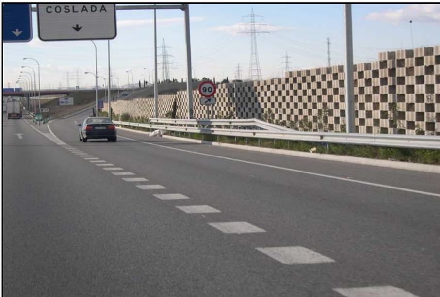
**Fotografía 10.10 Pantalla acústica con jardineras integradas en la M-45**
