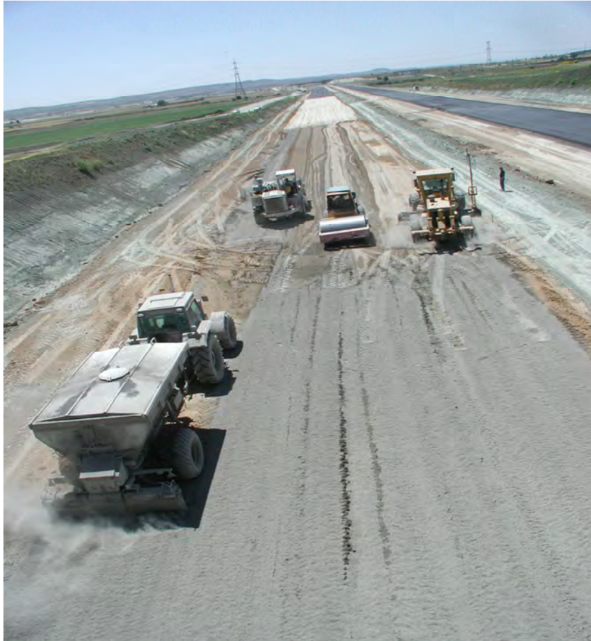
Foto 1: Equipo de estabilización in situ con cemento por vía seca y nivelación con 3D
