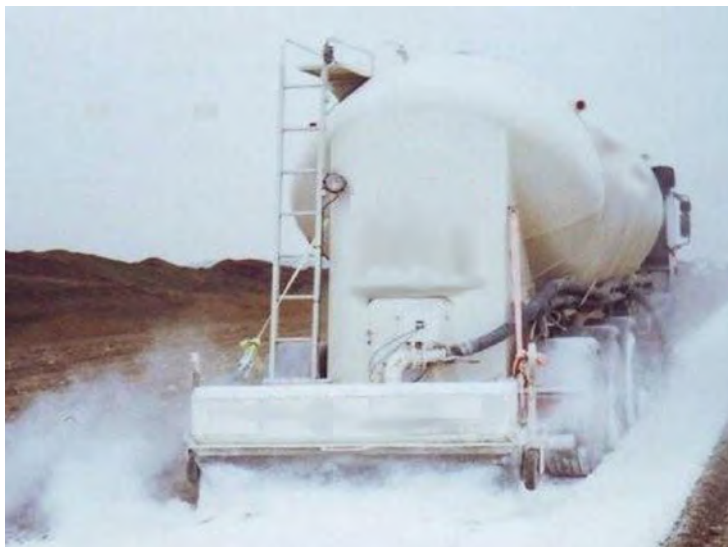
Foto 8: Distribuidor de conglomerante acoplado a cisterna de transporte
