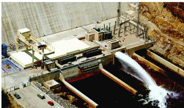
Foto.- Desagüe de fondo en operación fondo
