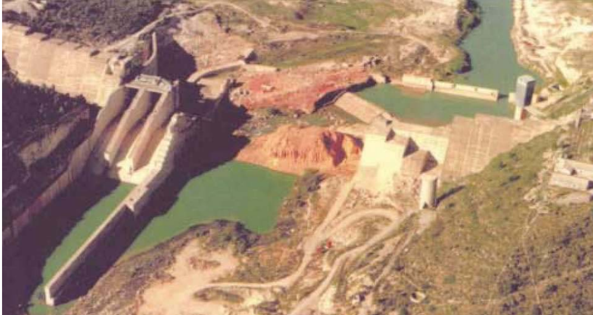
Foto.- Presa de Tous destruida por una avenida en 1982
