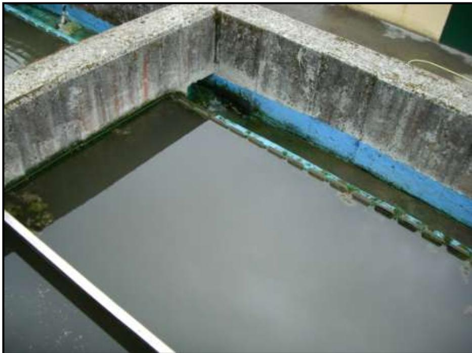
Figura 8. - Decantador secundario lamelar
