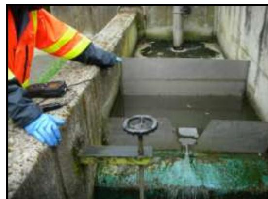
Figura 10. - Cámara efluente con vertedero triangular
