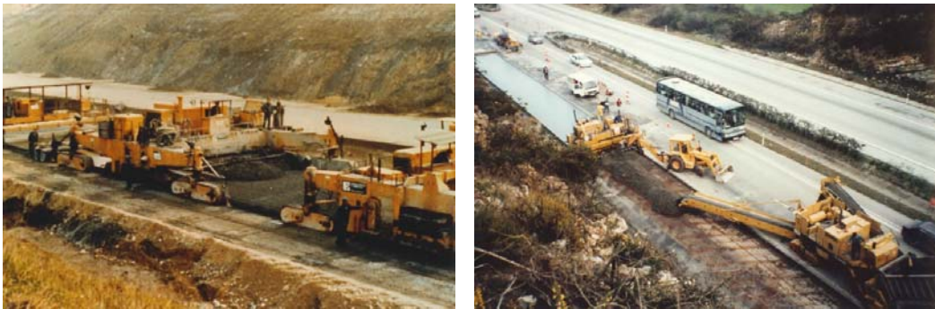
Preextendido, extendido, vibrado, textura y curado de un PCHA.
