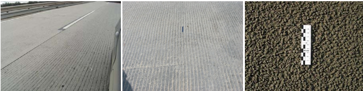
Texturas de estriado longitudinal, transversal y de árido visto.
