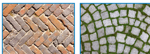
Gráfico 45. Ejemplos de pavimentos permeables. Ladrillo y losetas
