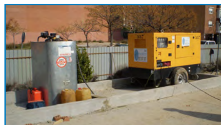
Gráfico 48. Detalle de zona habilitada para ubicación de grupo electrógeno y depósito de combustible
