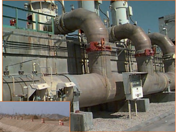
Instalación enterrada de una conducción DN2800 PN6
