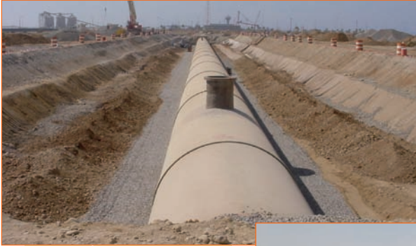
Bloque de distribución de tuberías en paralelo DN4000 PN9
