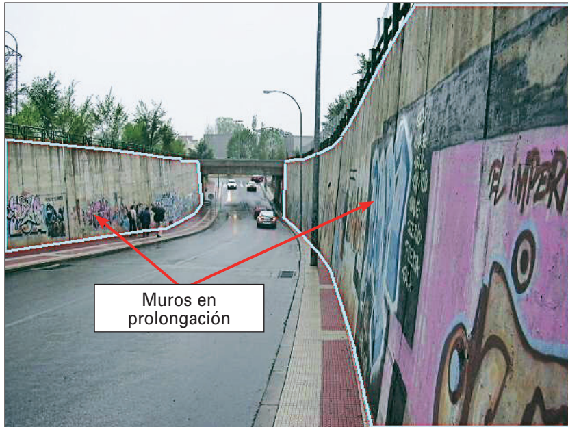
FIGURA 30. MUROS EN PROLONGACIÓN
