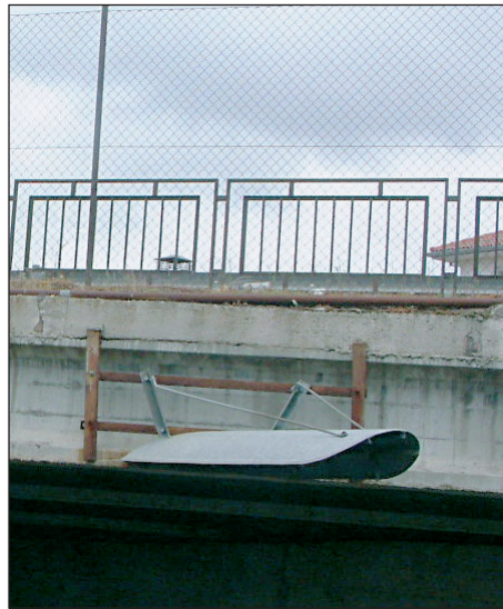
FIGURA 72. PROTECCIÓN DE CATENARIA
