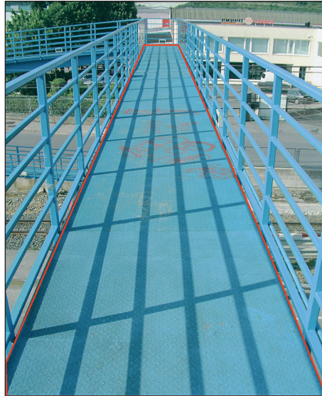
FIGURA 38. PAVIMENTO EN PASARELA (PINTURA ANTIDESLIZANTE.)
