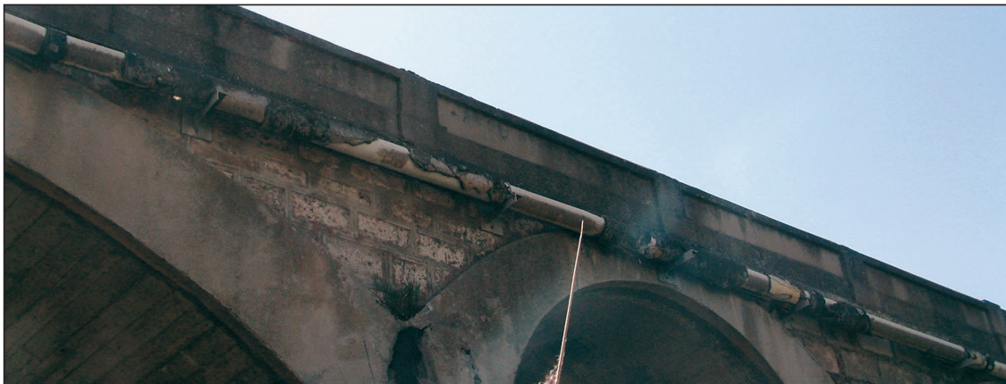
FIGURA 73. CONDUCCIÓN COLGANDO DEL TÍMPANO.
