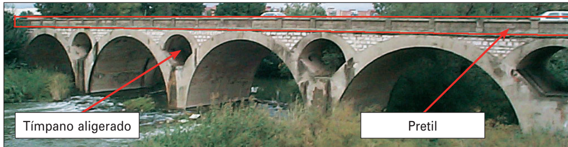
FIGURA 10. ELEMENTOS DE UNA BÓVEDA
