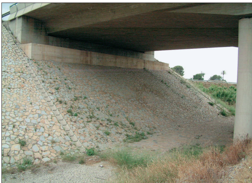
FIGURA 68. TERRAPLÉN ENCACHADO
