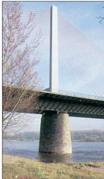
FIGURA 14. PUENTE ATIRANTADO
