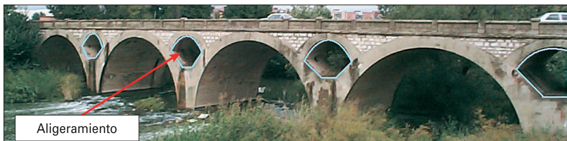
FIGURA 11. ELEMENTOS DE UNA BÓVEDA
