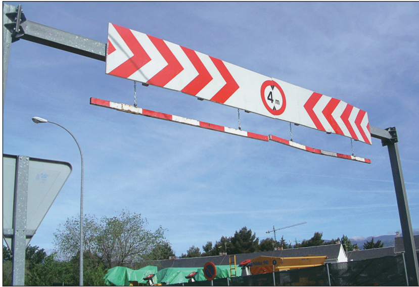
FIGURA 60. SEÑALIZACIÓN PREGÁLBO
