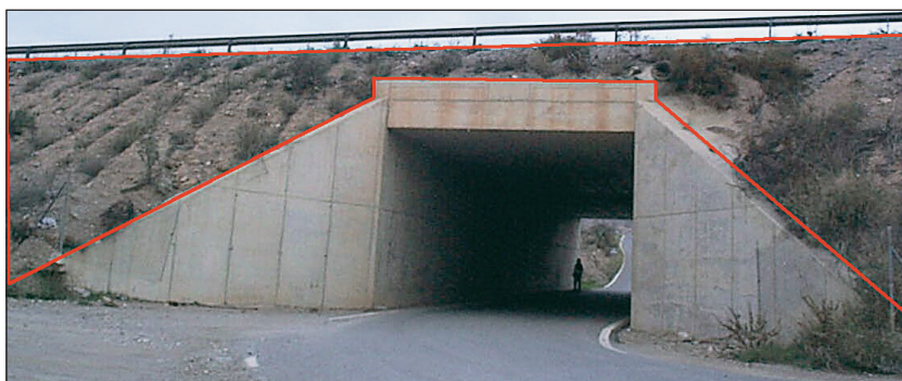
FIGURA 69. TERRAPLÉN CONTENIDO POR ALETAS E IMPOSTA.
