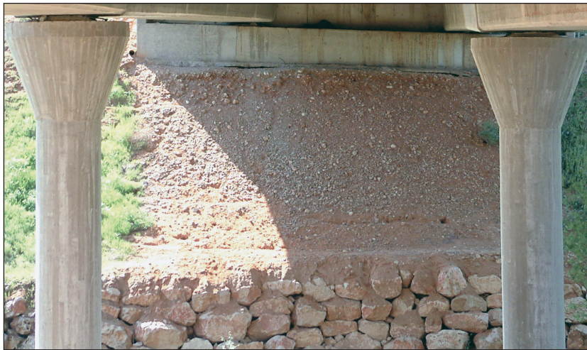
FIGURA 67. VIGA DURMIENTE SOBRE TERRAPLÉN.
