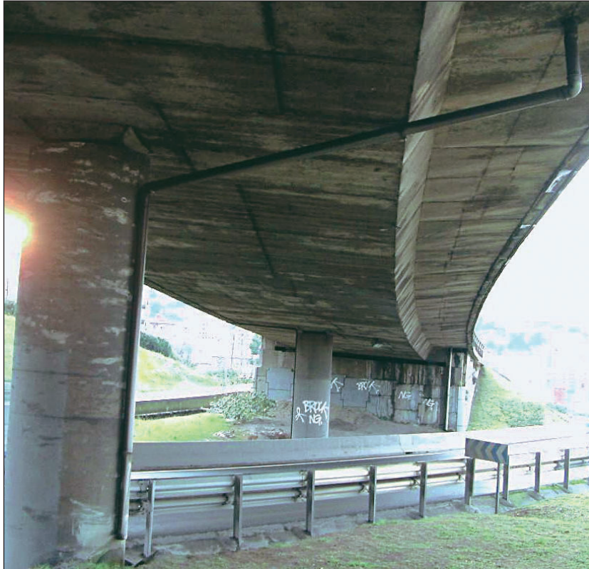
FIGURA 55. TUBO DE DESAGÜE
