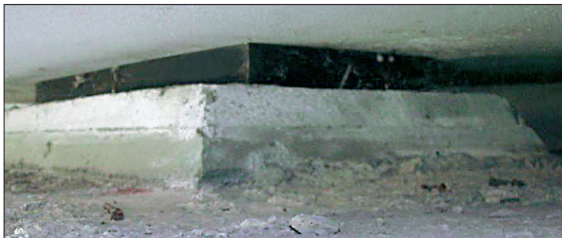
FIGURA 33. APARATO DE APOYO
