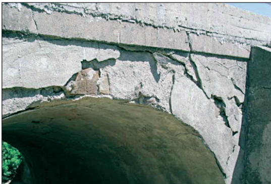
FIGURAS 28 Y 29. DETERIORO DEL REVESTIMIENTO (FOTOGRAFÍA IZQUIERDA) Y COLAPSO DE TUBO (FOTOGRAFÍA DERECHA)
