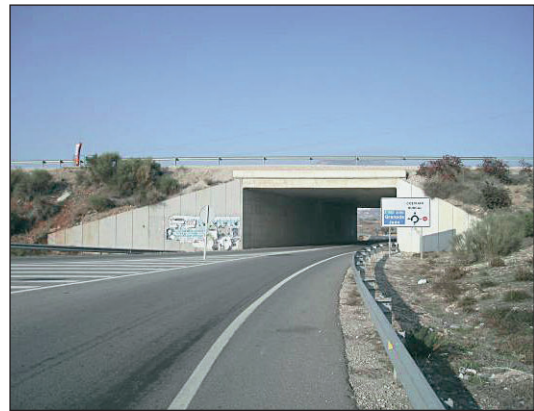
FIGURAS 3 Y 4. TABLERO SOBRE PILAS/ESTRIBOS
