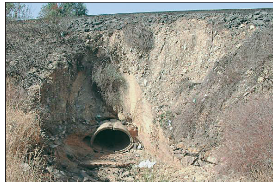
FIGURAS 28 Y 29. DETERIORO DEL REVESTIMIENTO (FOTOGRAFÍA IZQUIERDA) Y COLAPSO DE TUBO (FOTOGRAFÍA DERECHA)
