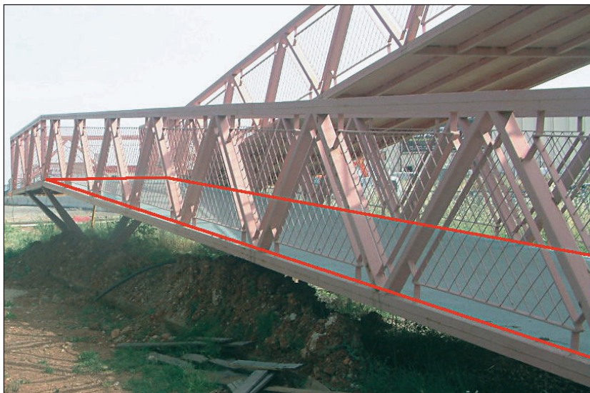
FIGURA 39. PAVIMENTO EN PASARELA
