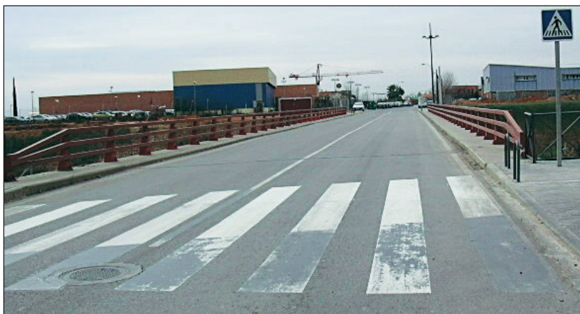
FIGURA 62. SEÑALIZACIÓN HORIZONTAL Y VERTICAL
