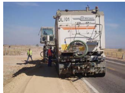
Foto 18. La dosificadora de lechada se hunde en un suelo arenoso
