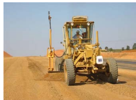
Foto 23. Nivelación de un suelocemento con equipo dotado de 3D
