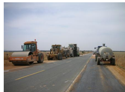
Foto 25. Equipos de suelocemento in situ en un ensanche
