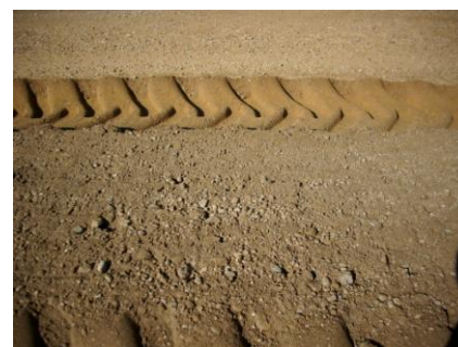
Foto 6. Detalle del suelocemento realizado in situ
