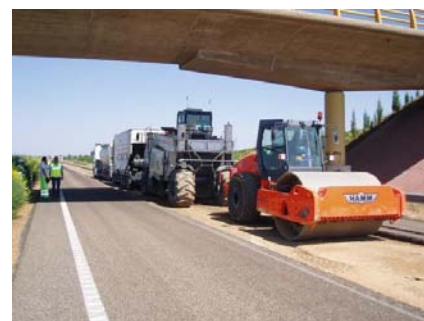
Fotos 8 y 9. Diferentes tipos de suelocemento realizados in situ (barridos y limpios)
