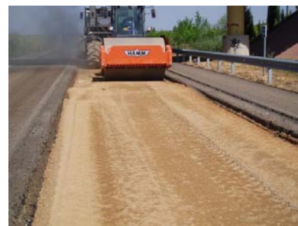
Fotos 10 y 11. Rehabilitación de un carril mediante la técnica de suelocemento in situ
