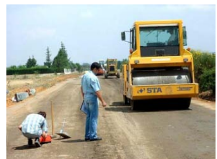
Fotos 15 y 16. Control de espesores, humedad y densidad
