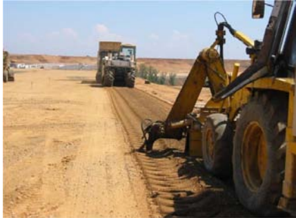
Foto 24. Equipo prefisurando un suelocemento realizado in situ
