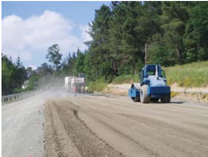
Foto 12. Perspectiva de los equipos y la compactación
