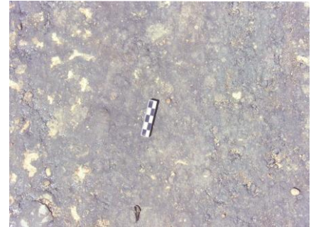
Foto 26. Detalle de la terminación del suelocemento realizado in situ correctamente
