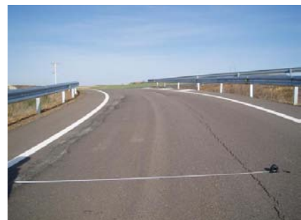
Fotos 19 y 20. Fisuras aparecidas por fallo de algún inyector y calicata de comprobación
