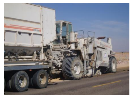
Foto 1. Equipos realizando un suelo cemento in situ en ensanche
