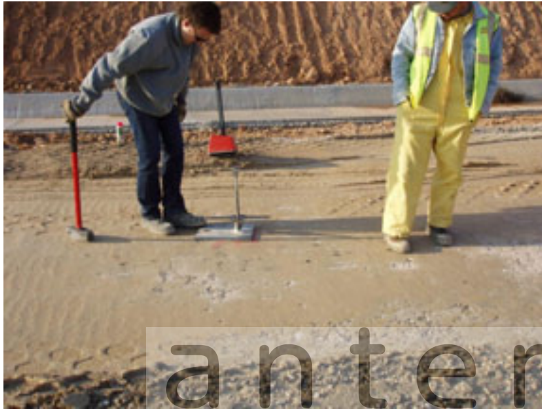
Fig. 6 Control de la densidad obtenida
