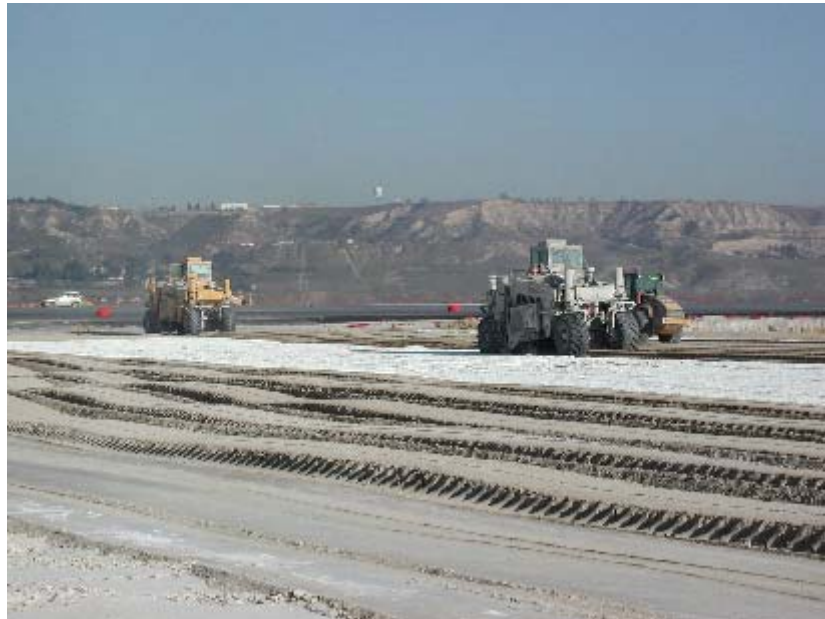
Foto 3: Estabilización mixta en las pistas del Aeropuerto de MAD-Barajas.
