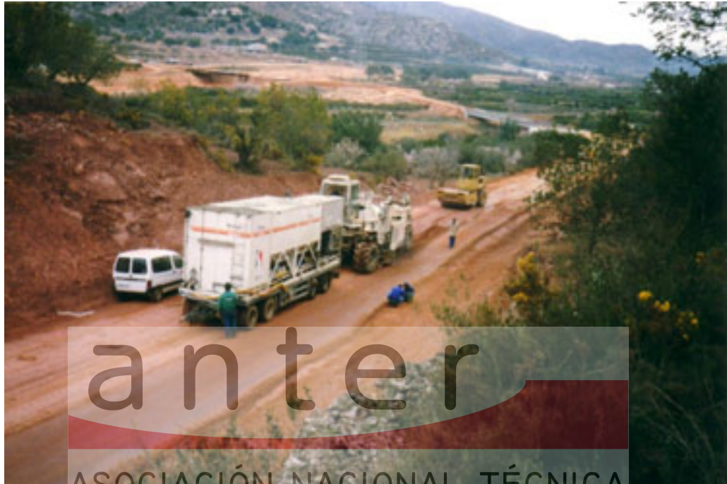
Fig. 2 Equipo para la fabricación de suelocemento in situ
