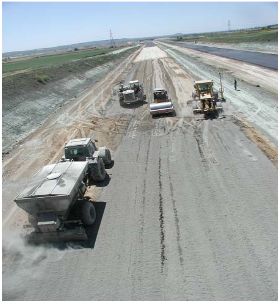
Foto 2: Estabilización con cemento por vía seca.
