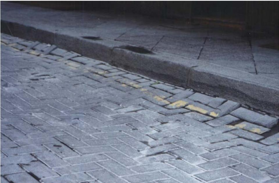
Fig. 4.15 – Firme adoquinado en mal estado debido al colapso de las capas inferiores
