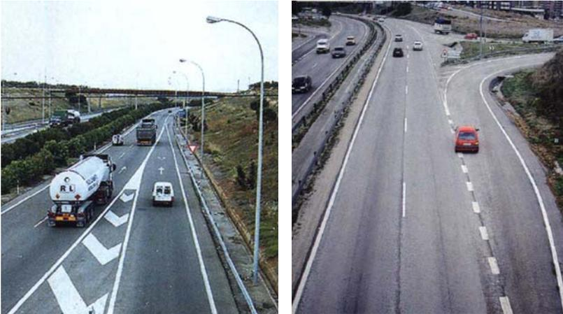
Fig. 4.8 – Carriles de aceleración y deceleración
