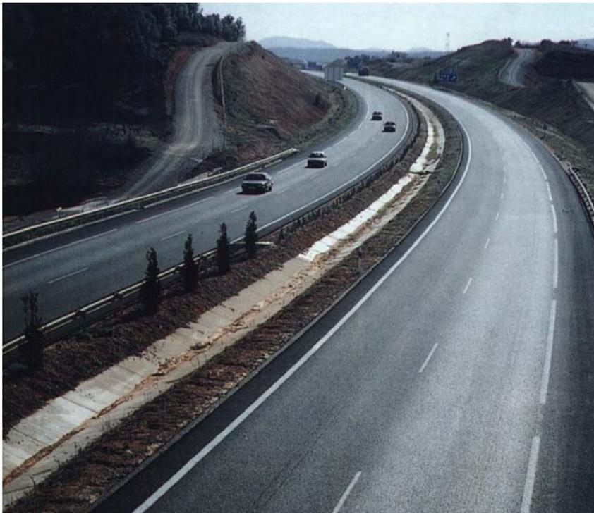
Fig. 13.11 – Mediana separadora de calzadas en la N-III
