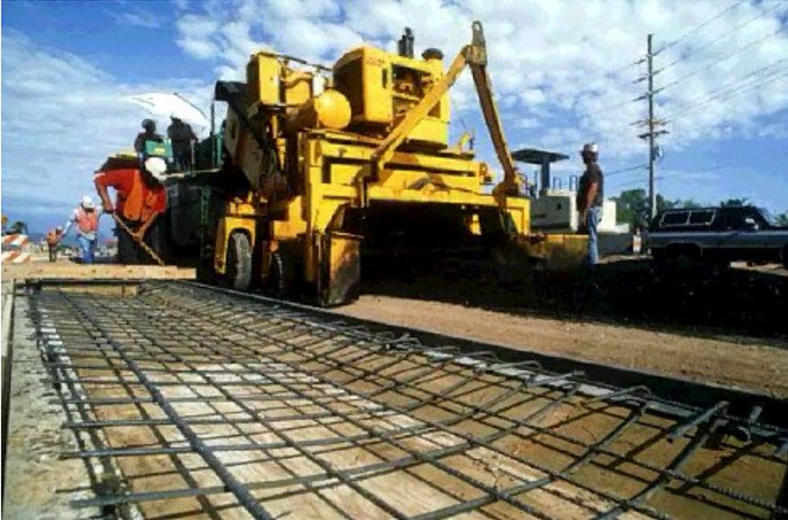
Fig. 1.8 – Extensora vertiendo el hormigón que conforma la capa de rodadura
