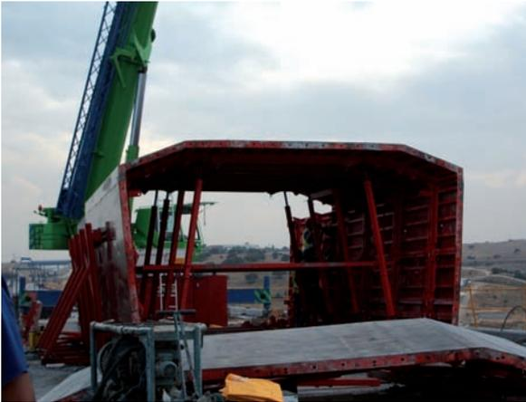
Transporte en obra de encofrado interior premontado
