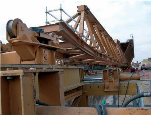
Entrada a los rodillos de pila durante el lanzamiento
