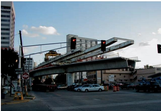
Tablero curvo de dovelas prefabricadas
