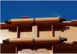
Unión con barra pretensada
