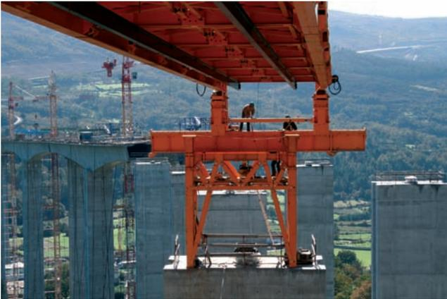
Torres de apoyo en pila para cimbra sobre tablero
