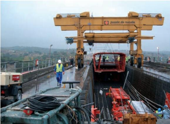
Medios auxiliares complejos: pórtico, automóvil, carro de extracción
