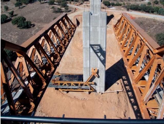
Montaje de la estructura de apoyo en pila
