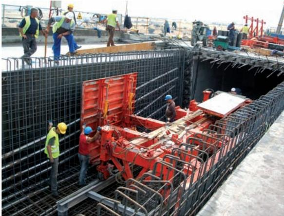
Carro de extracción de encofrado interior
