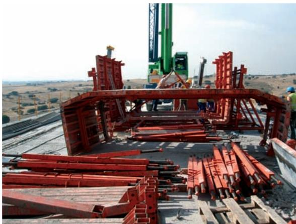
Transporte de encofrado interior
