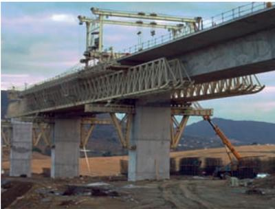
Pórtico auxiliar de transporte de encofrados armadura y viga de cuelgue
