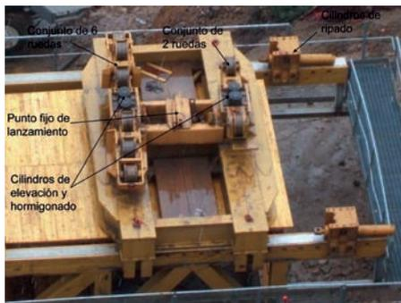
Cilindros de elevación, ripado y mesa de rollers
