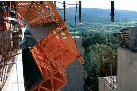
Apertura de encofrado para evitar interferencia pila
