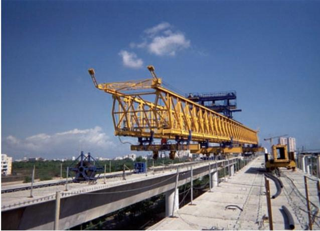
Cimbra autolanzable para dovelas prefabricadas vano a vano
