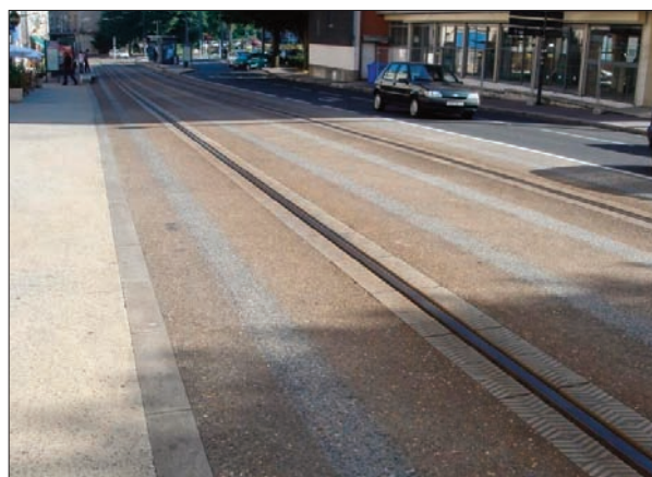
Figura 4 - Plataforma reservada en Rouen (Teor BRT). La tracción es diesel y dispone de guiado óptico.
