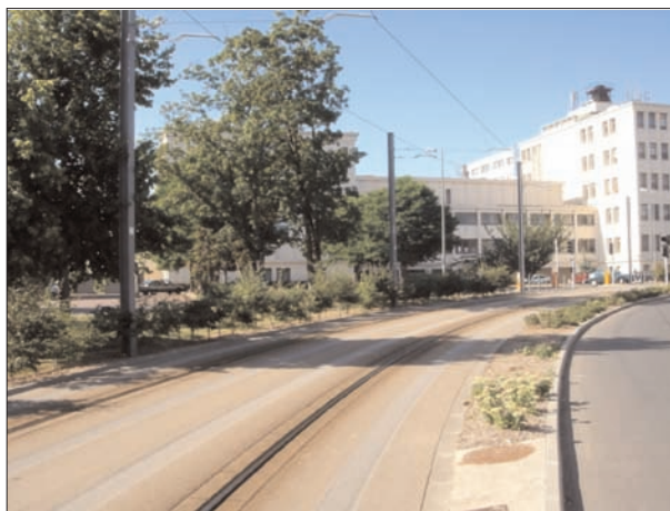
Figura 12- Roderas en una plataforma reservada sin pavimento de hormigón.
