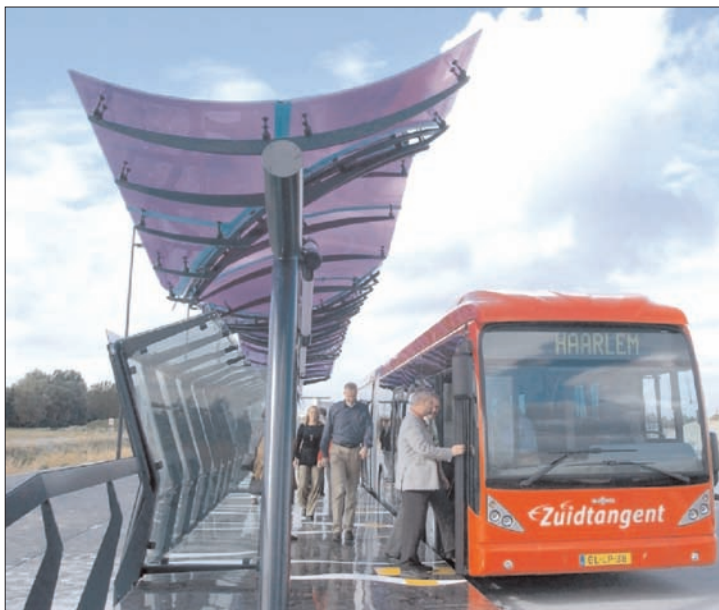
Figuras 8 y 9 - Plataforma reservada en Amsterdam (Zuidtangent). La tracción es diésel y no dispone de guiado
