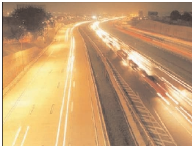
Figura 14 - Autopista Presidente Castelo Branco en Sao Paulo (Brasil). Calzada izquierda de hormigón y derecha de mezclas bituminosas.
