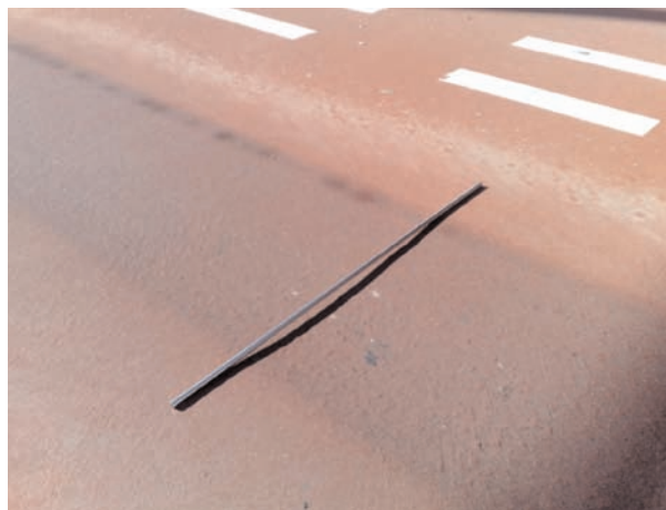
Figura 12- Roderas en una plataforma reservada sin pavimento de hormigón.
