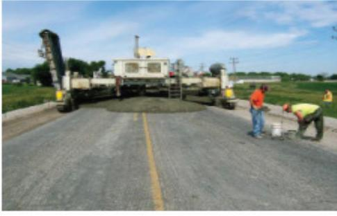
Extensión de hormigón sobre firme bituminoso fresado previamente para regularizar el espesor del refuerzo
