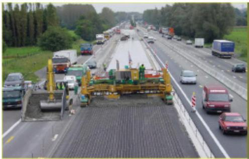
Refuerzo con pavimento continuo de hormigón armado
