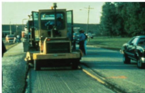
Fresado de mezcla bituminosa para mejorar la adherencia
