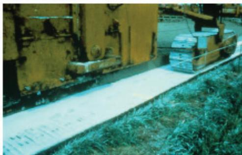
Riego previo con producto de color blanco para disminución de la temperatura de la mezcla bituminosa
