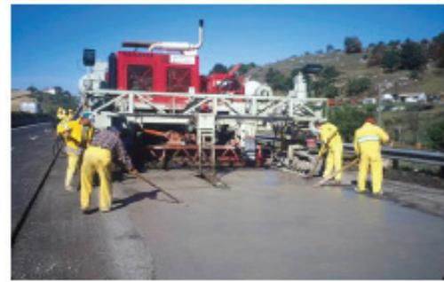
Extensión de un refuerzo de hormigón (inlay) en una caja abierta en el firme existente
