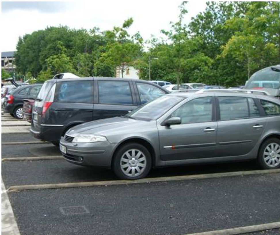
Plazas de mezcla bituminosa en el aparcamiento experimental de la Guía, en Gijón.
