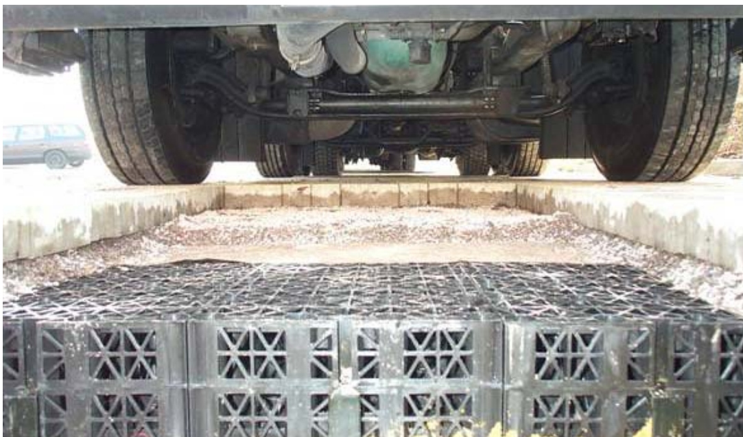
Figura II-6. Subbase de estructuras de plástico de Permavoid Limited (2008).
