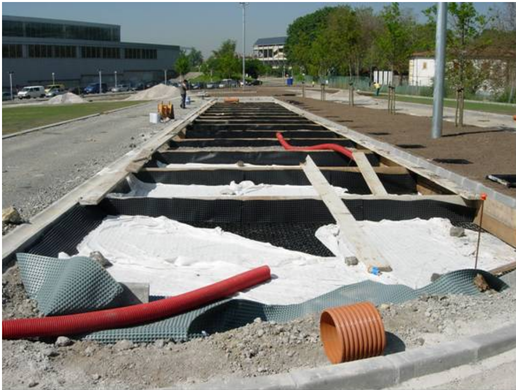
Geotextil de fondo en el aparcamiento experimental de la Guía, en Gijón.
