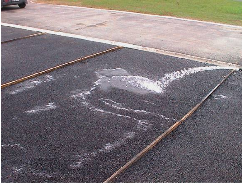
Mezcla bituminosa porosa en el aparcamiento experimental de la Guía, en Gijón.
