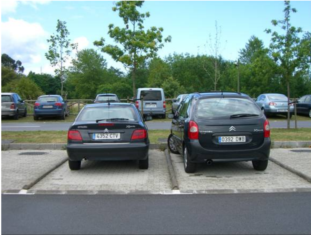
Plazas de adoquines en el aparcamiento experimental de la Guía, en Gijón.
