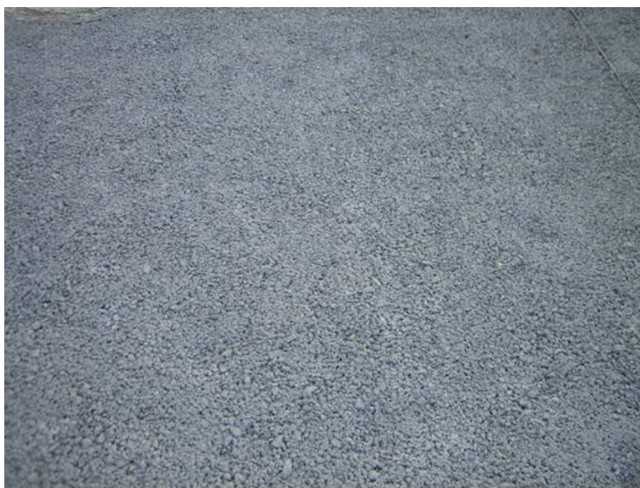
Figura II-5. Hormigón poroso hidráulico, aparcamiento experimental del Parque de las Llamas, Santander.
