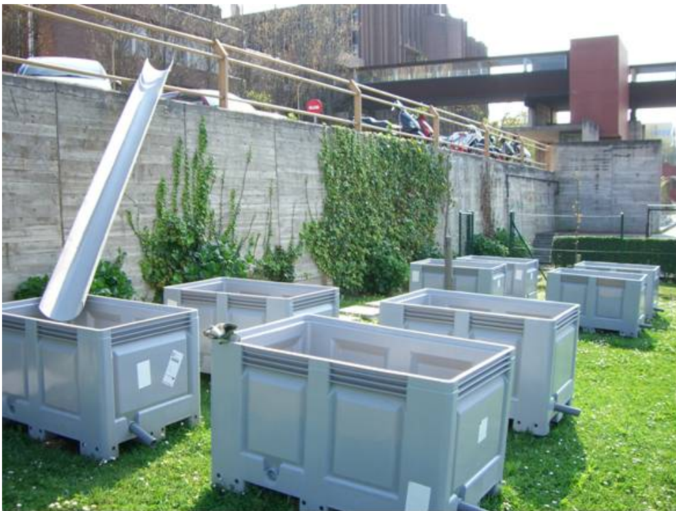
Puesta en obra de los áridos en los contenedores del Campus de Santander.
