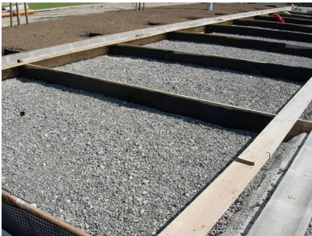
Zahorra drenante en el aparcamiento experimental de la Guía, en Gijón.
