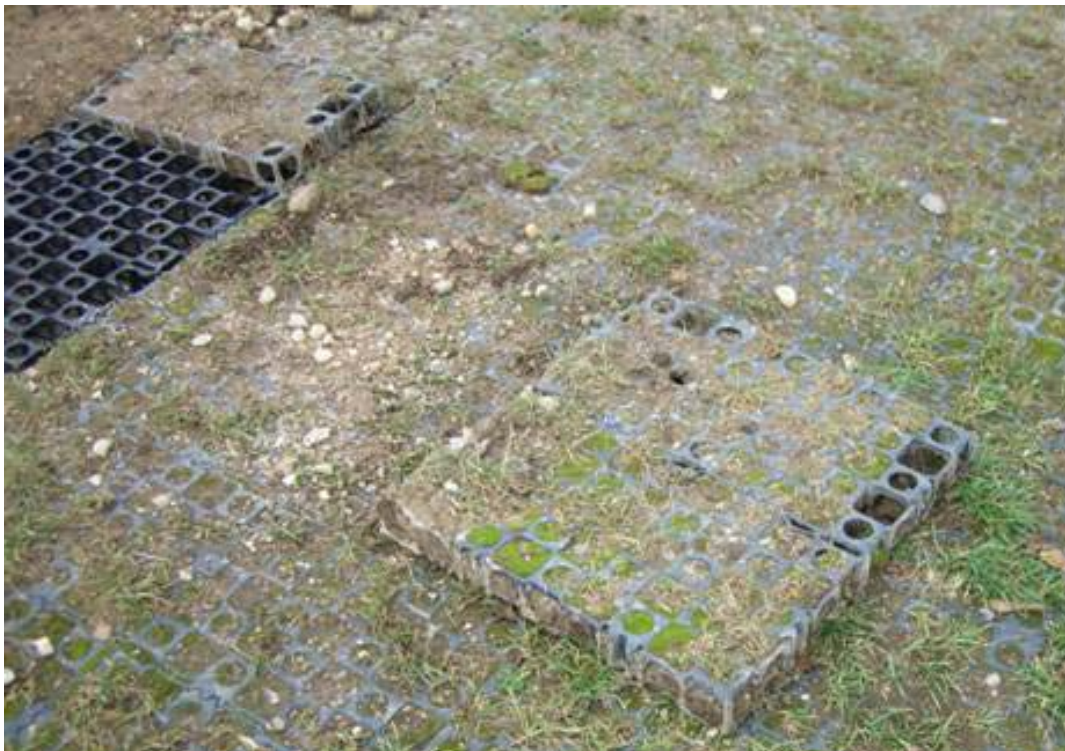
Figura II-2. Césped con refuerzos de plástico, aparcamiento del Palacio de Deportes de la Guía, Gijón, Asturias.
