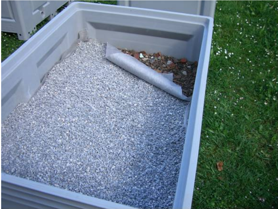
Geotextil de filtro y separación y base de los contenedores del Campus de Santander.
