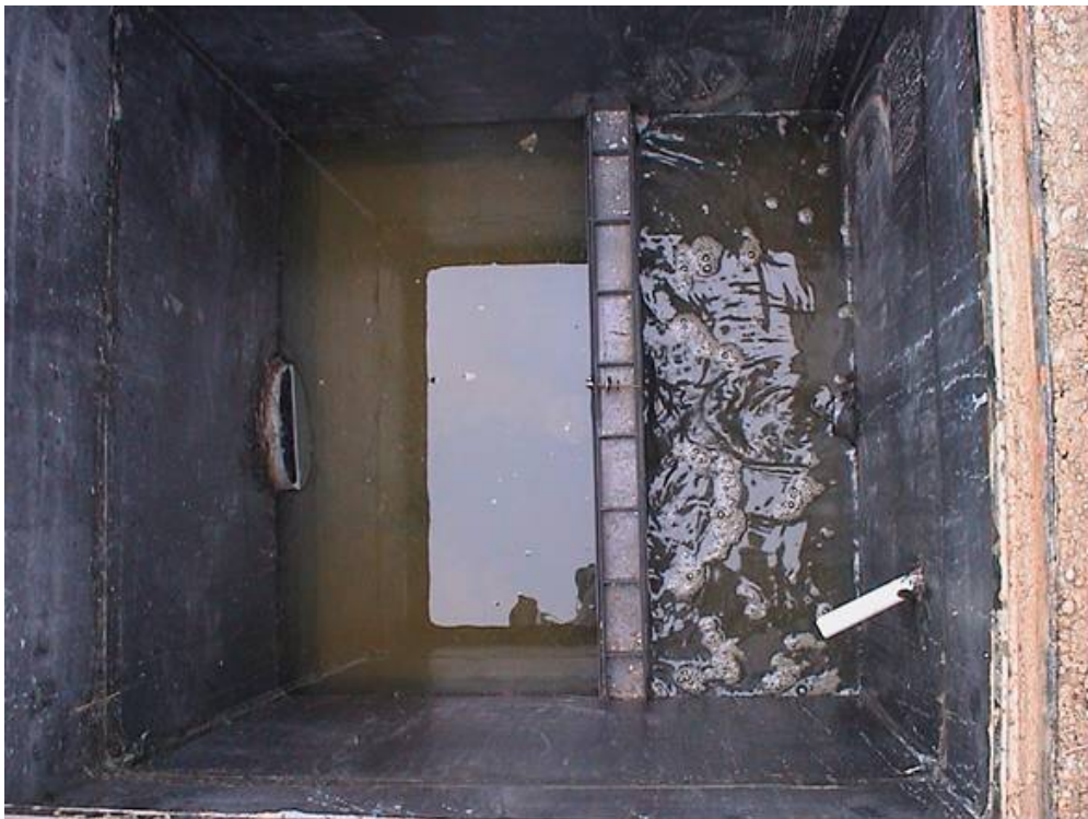
Efluente en el aparcamiento experimental de la Guía, en Gijón.
