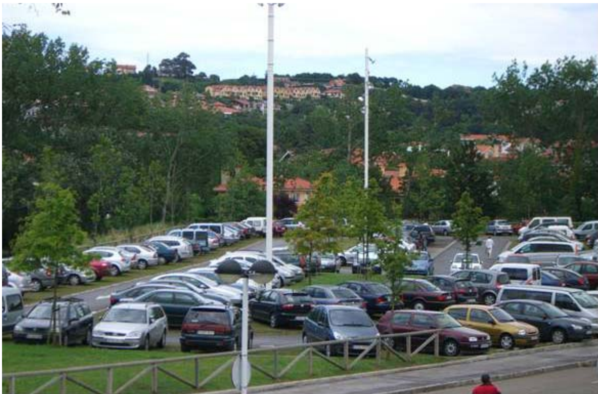
Figura IV-68. Plazas de aparcamiento experimentales construidas con firmes permeables ocupadas por vehículos ligeros, aparcamiento público del Palacio de Deportes de la Guía, Gijón.
