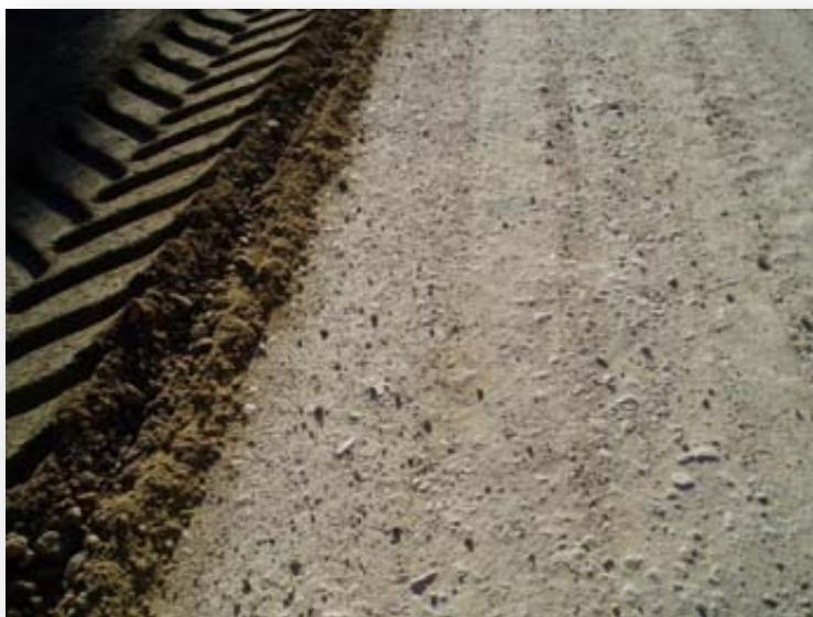
Fig. 20 Detalle de la granulometría de un suelo estabilizado con cemento en Cantalejo
