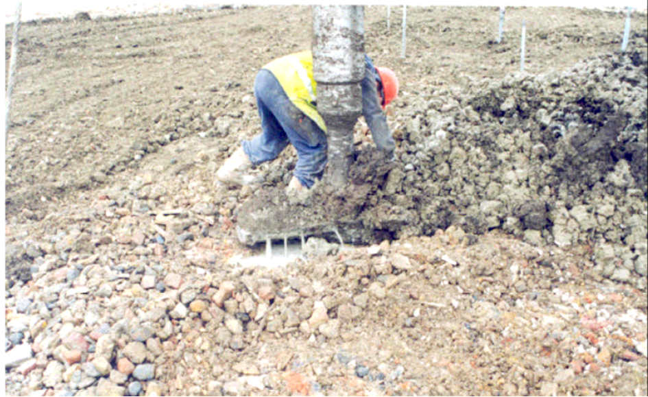
Foto 4: Descontaminación de suelos mediante lechada de cal.
