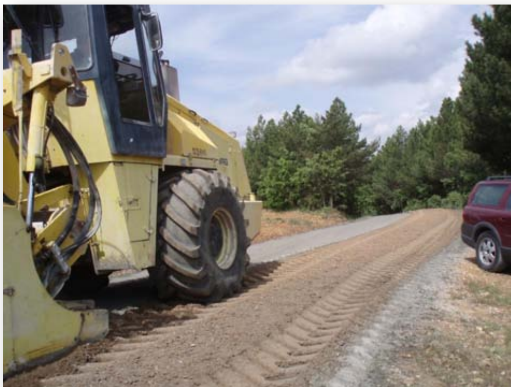
Fig. 26 Camino del pinar de Rio Camba. Ejecución de los trabajos de estabilización con cemento
