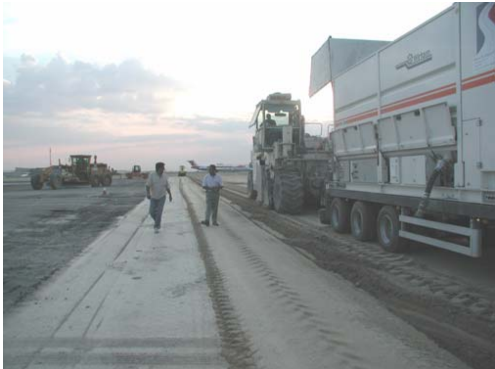
Foto 2: Ejecución del tratamiento con cemento por vía húmeda.
