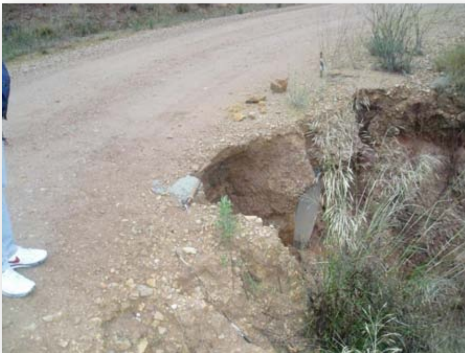
Fig. 23 Pese al mal funcionamiento del drenaje transversal, el suelo estabilizado impide que esta cárcava corte completamente el paso del camino
