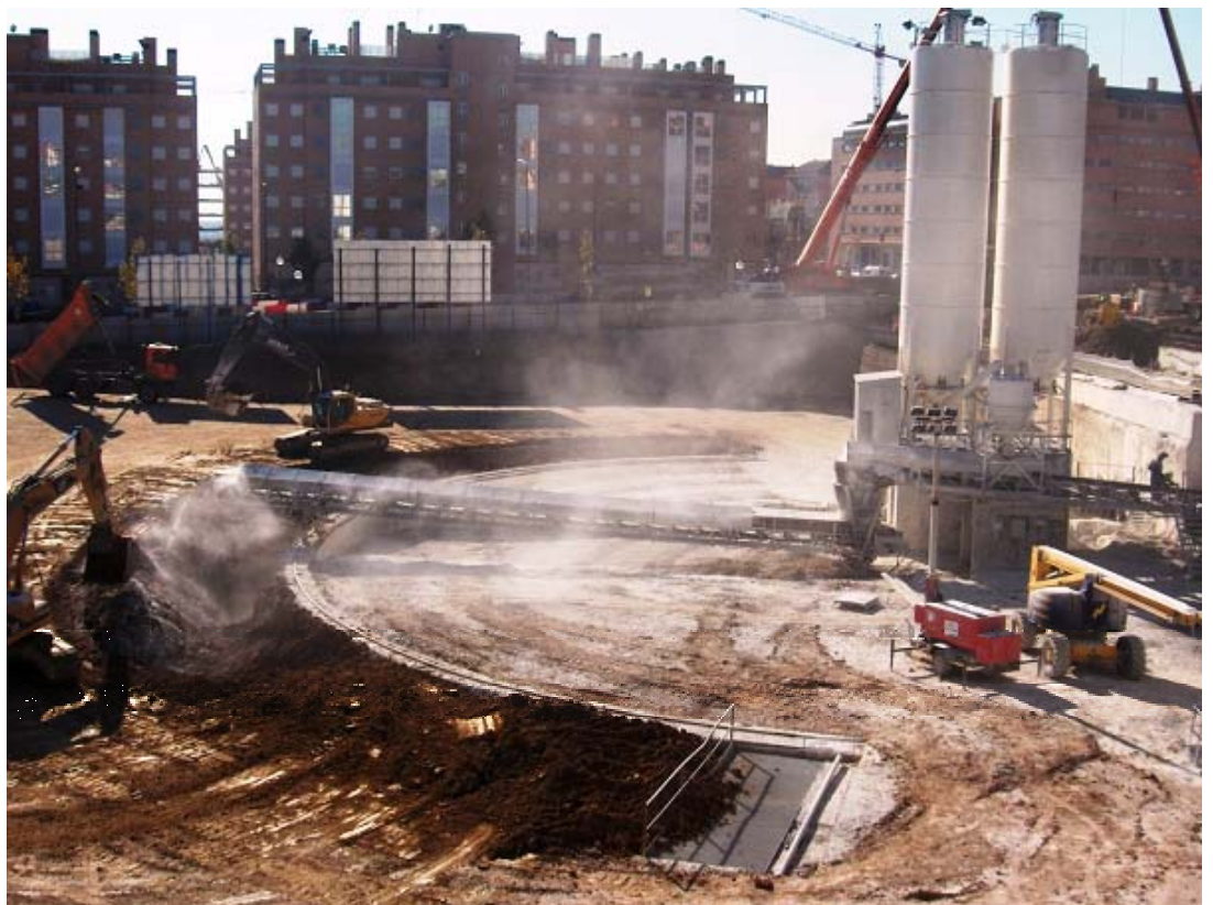
Foto 3: Secado y estabilización de los lodos en las obras de Metro de Madrid.
