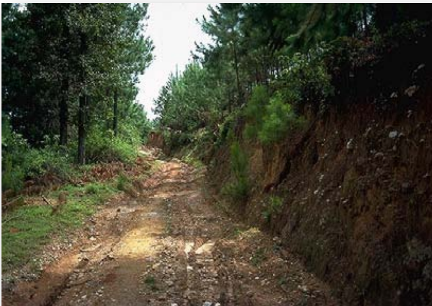
Fig. 10 Camino muy deteriorado por lluvias, tráfico y una falta de mantenimiento
