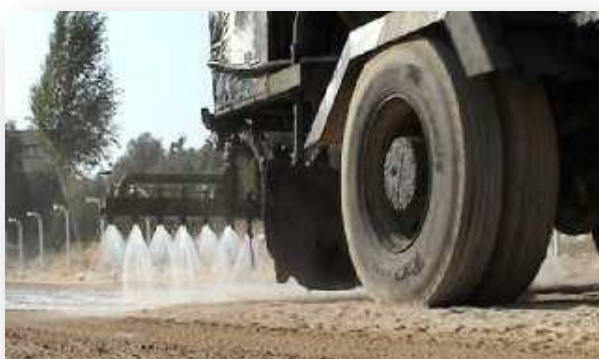
Fig. 18 Extendido de un conglomerante antipolvo
