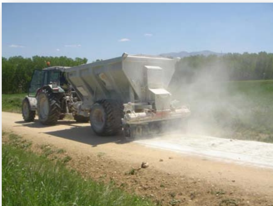
Fig. 19 Repartidor de cal en polvo en un camino de Segovia
