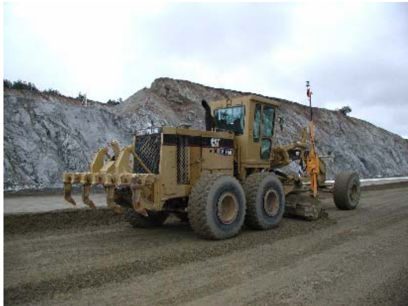
Foto 1: Trabajos de nivelación tras la estabilización de la capa (SOLTEC).
