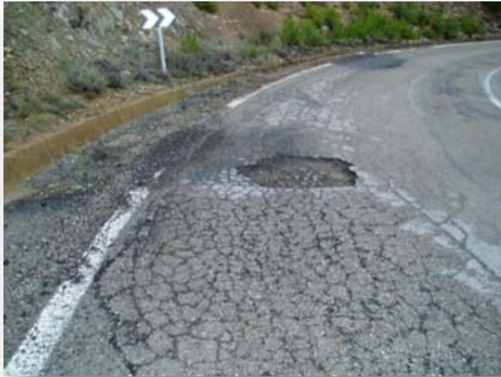
Fig. 22 Deterioro producido en una carretera por la que han tenido que pasar los camiones cargados con el material para una reparación tradicional
