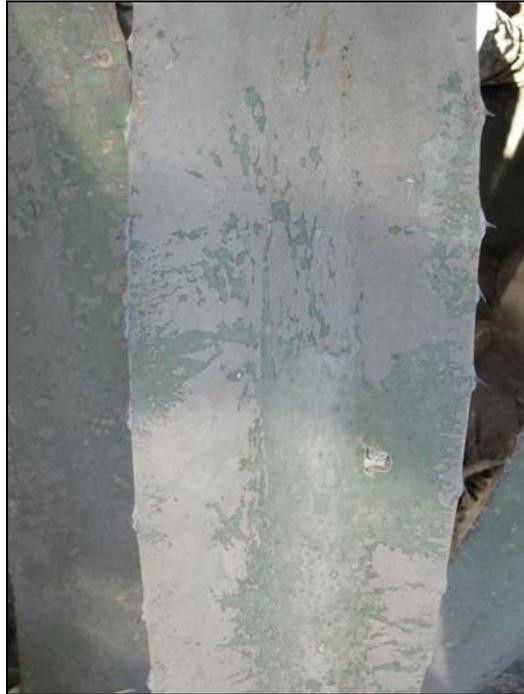
Fotografía 12. Detalle de incrustaciones debidas a la contaminación. Carretera C-31
