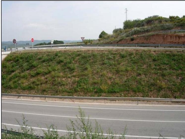
Fotografía 15. Estabilización de taludes. Carretera C-15
