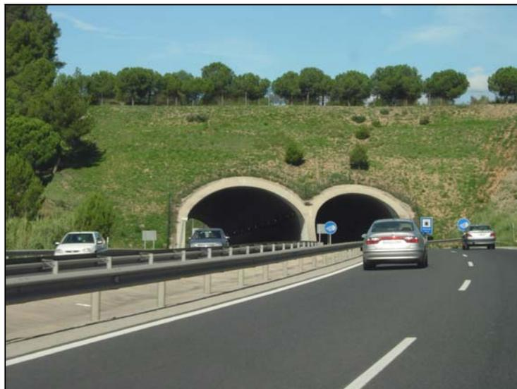
Fotografía 89. Falso túnel en la carretera C-16
