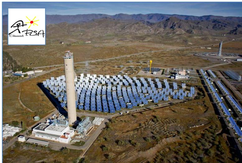
Concentrador de Torre en la Plataforma Solar de Almería (PSA)
