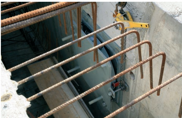
Figura 26. Apoyo POT instrumentado en estribo E1
