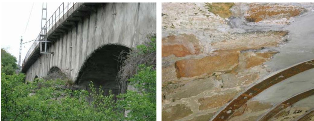
Figura 3.55. Ejemplos de deficiencias debidas a intervenciones anteriores.
