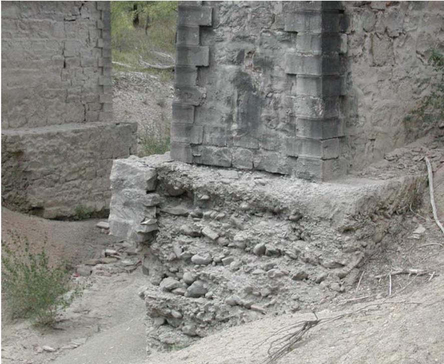
Figura. 3.18. Ejemplo de deterioro del elemento estructural zapata de un puente de fábrica.
