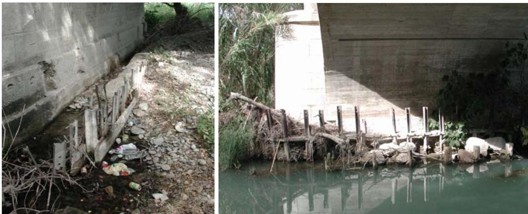
Figura 3.26. Corrosión de elementos metálicos en recintos tablestacados.
