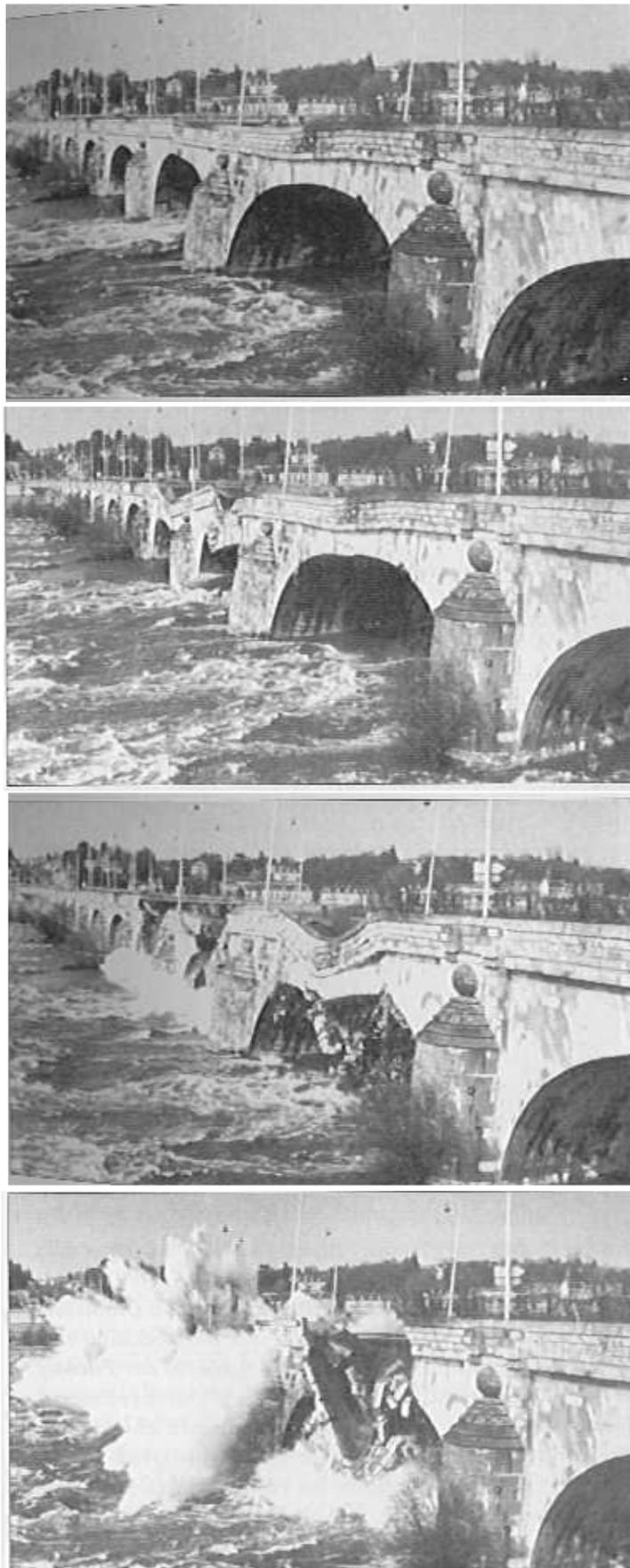
Figura 3.15. Colapso del puente de Tours (abril de 1978).
