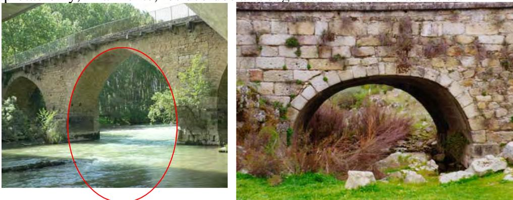
Figura 23. Distorsiones inducidas en un puente por problemas de cimentación de la pila derecha (figura izquierda). Deformaciones producidas durante la construcción por movimientos de la cimbra (figura de la derecha), como se deduce del hecho de que las hiladas superiores no presentan distorsión. El ingeniero debe estar atento a estas consideraciones.
