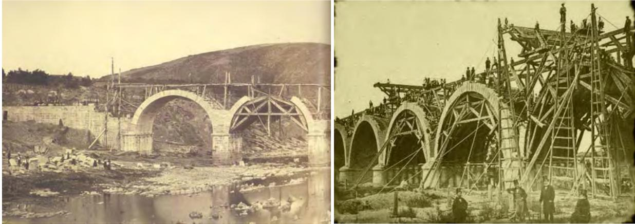
Figura 4. Construcción de puentes en el s. XIX. Una tradición constructiva perdida. A la izquierda, construcción de un puente sobre el río Tera (Zamora), foto de Laurent, y construcción del Puente de los Franceses (Madrid).
