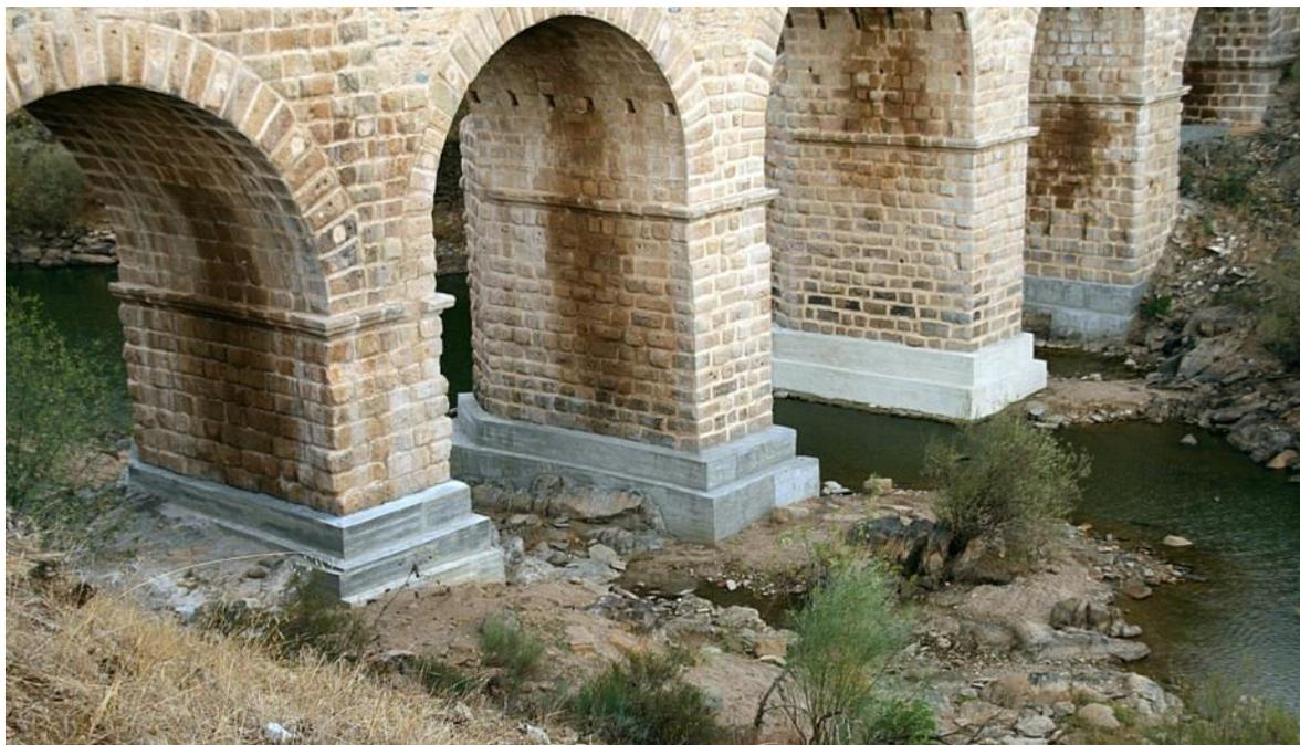
Figura 8.- Vista general desde la margen derecha de los encamisados de hormigón de las bases de las pilas.
