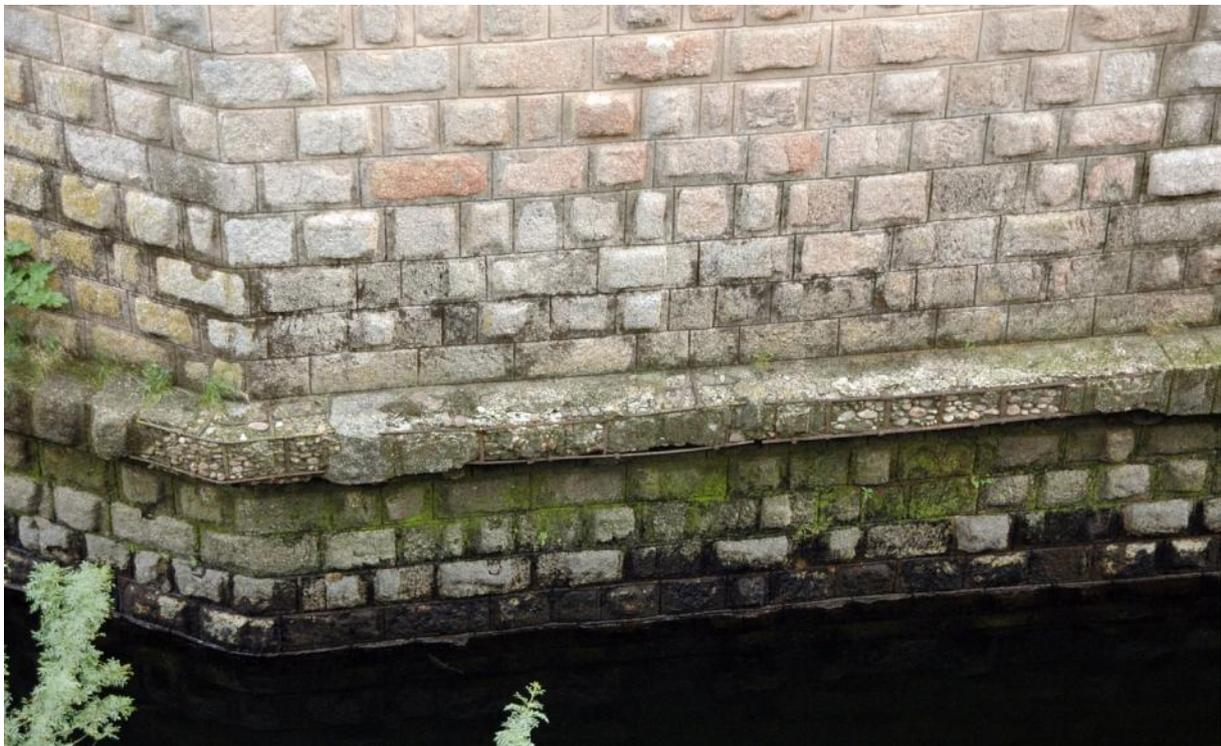
Figura 1.- Reconstrucción deteriorada de una cornisa del puente de Alcántara con hormigón armado.
