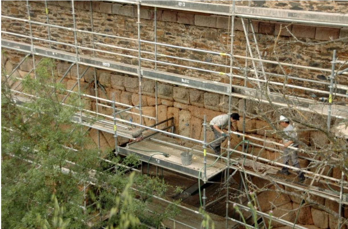
Figura 6.- Taladrado de las bóvedas para introducción de los bulones de atado.
