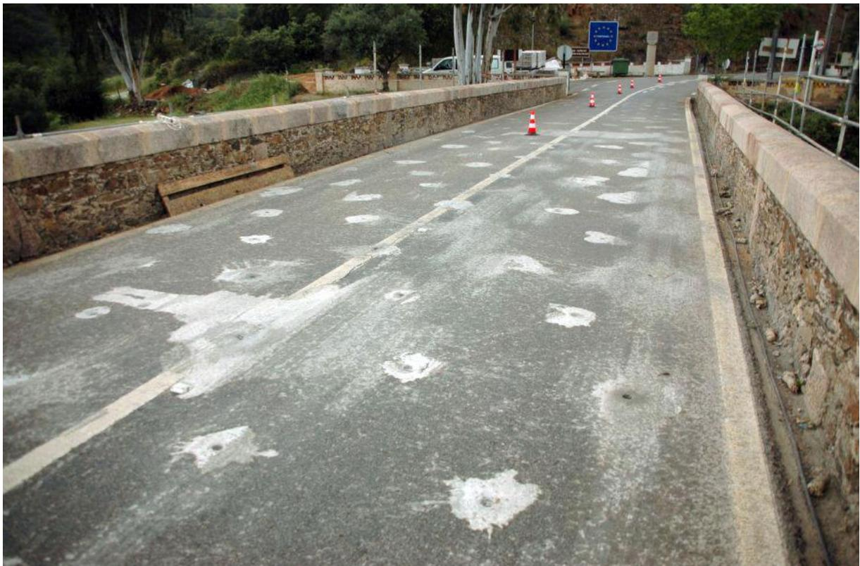
Figura 7.- Perforaciones verticales para la inyección de los rellenos.
