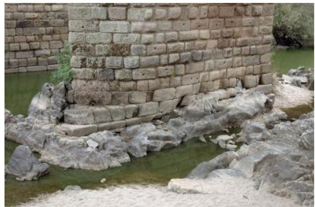
Figura 14.- Base de la pila 3 enfundada en un dado de hormigón armado y antes de esta operación.
