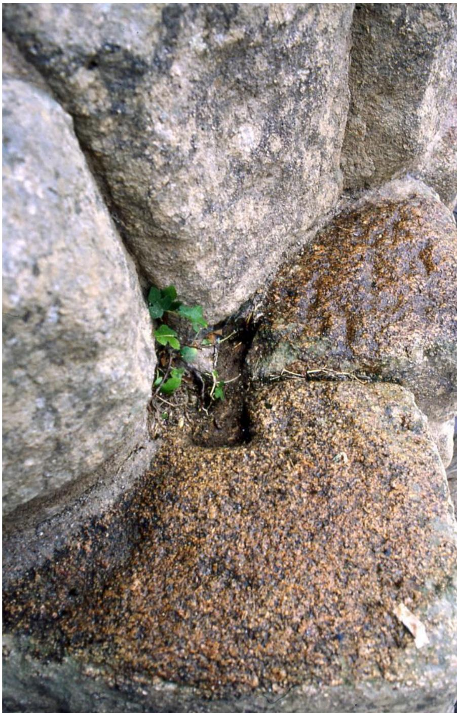
Figura 4.- Mortajas con forma de colas de milano en los sillares de cimentación de una pila
