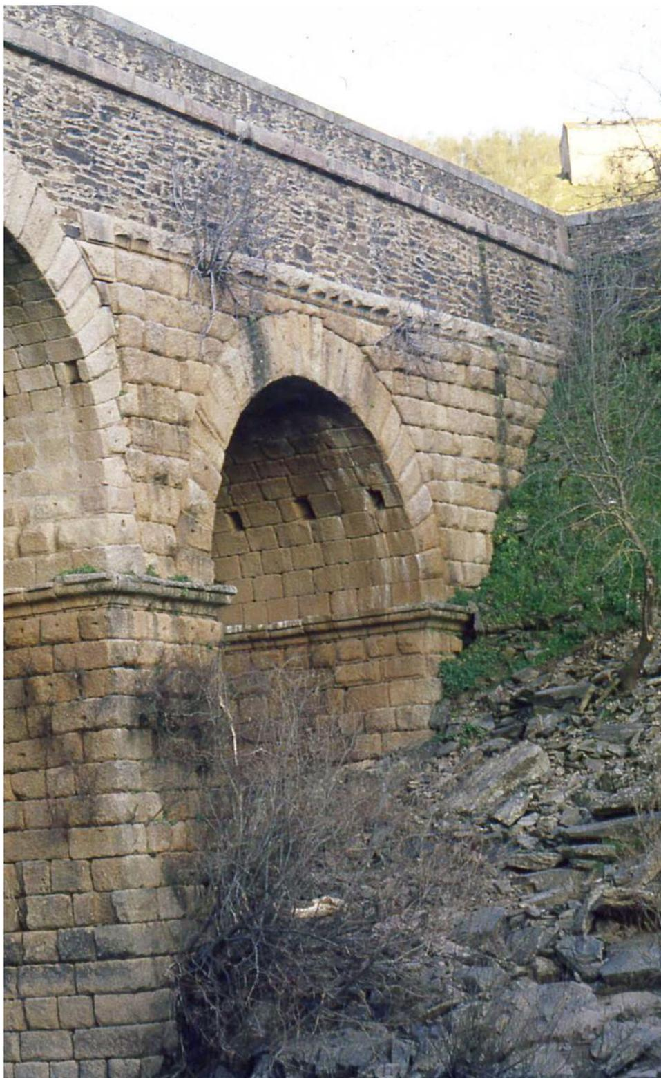
Figura 3.- Alzado aguas abajo del arco romano de la margen izquierda antes de la restauración
