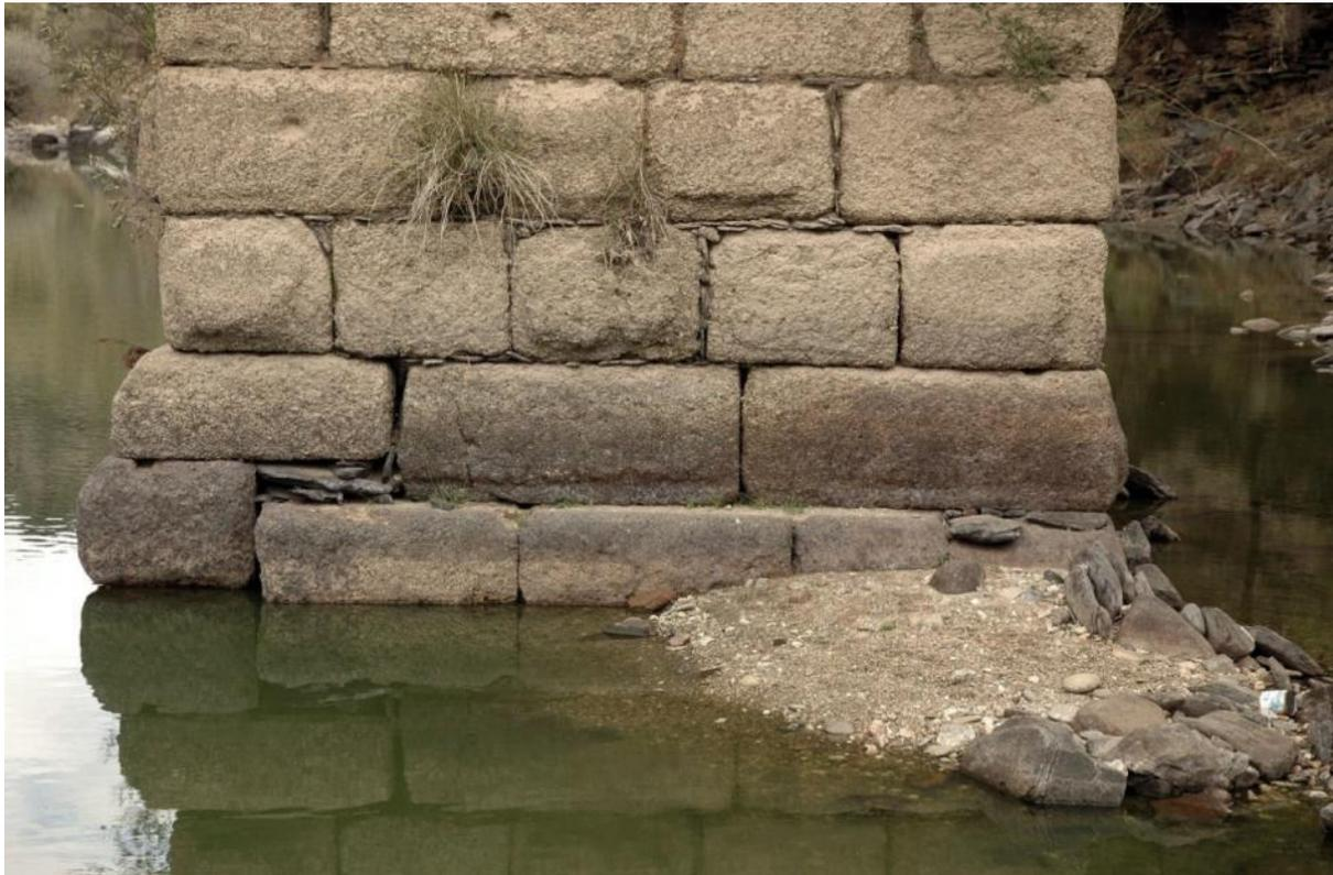
Figura 13.- Fábricas romanas y del XVI en la pila 2 antes de ser encamisada con hormigón armado.
