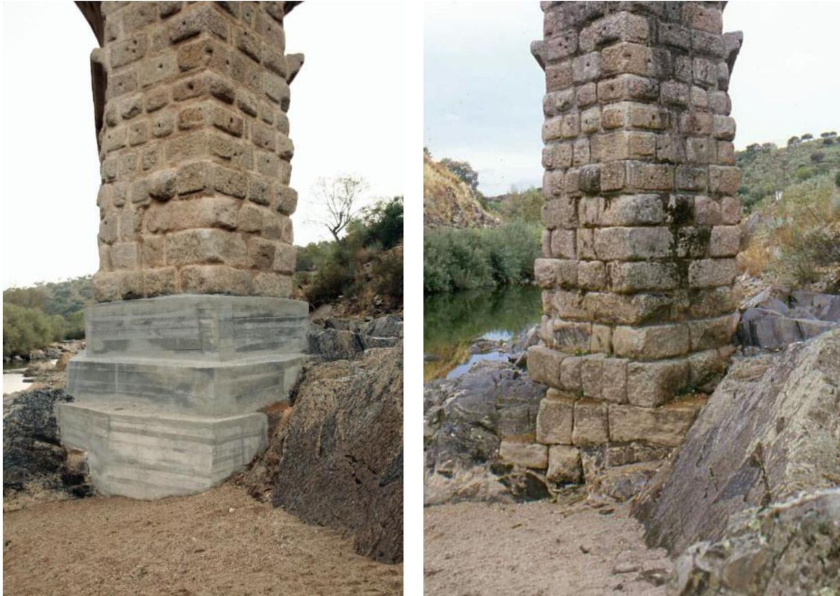
Figura 14.- Base de la pila 4 romana enfundada en un dado de hormigón armado y antes de esta operación.
