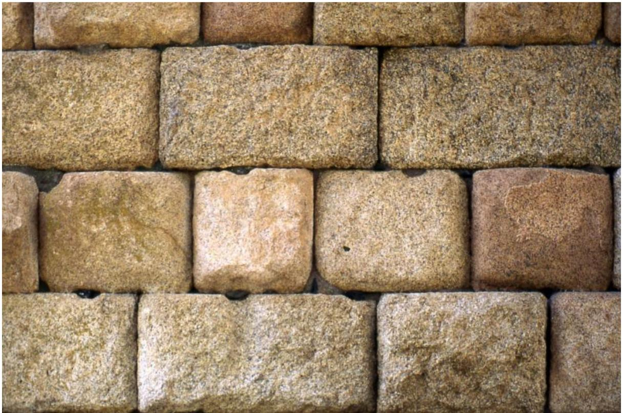
Figura 15.- Contraste entre los paramentos con sus juntas con y sin relleno de mortero.
