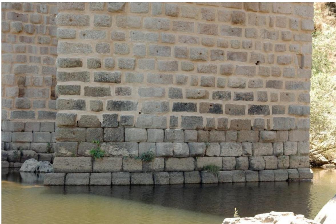
Figura 9.- Pila parcialmente rejauntada con mortero de cemento, todavía sin encamisado de su base.
