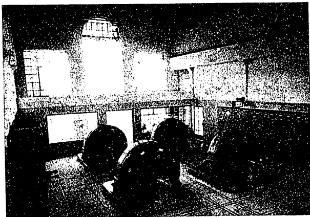
Fig. 11. — Sala de máquinas.
