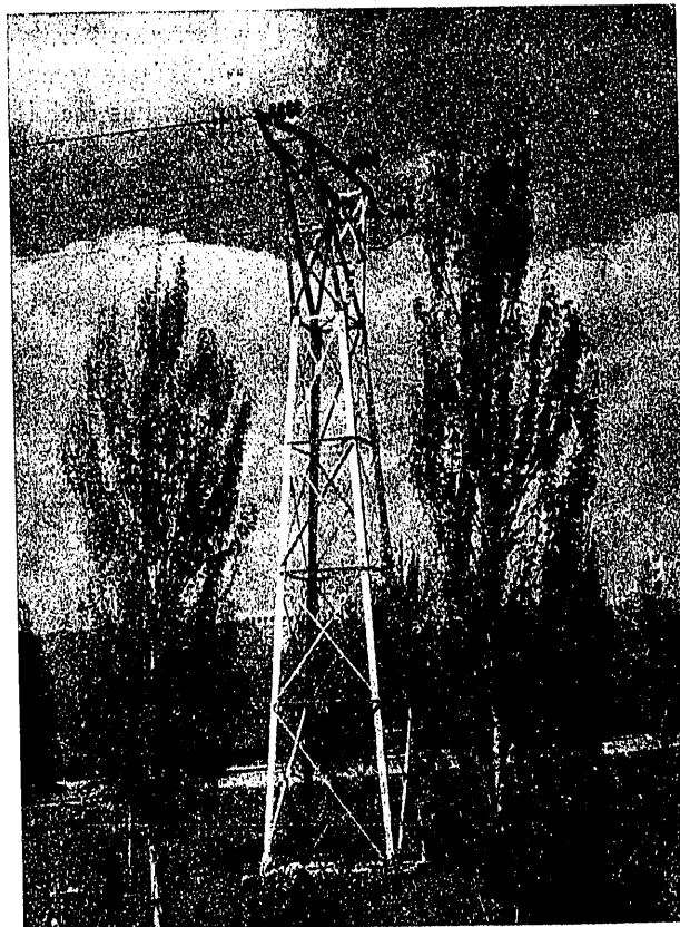
Vista general de uno de los postes.
