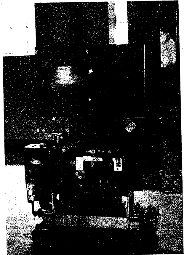
Fig. 15. — Disyuntor extrarrápido negativo.
