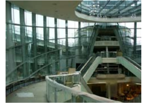
Neubau Centermall Spreitenbach, Switzerland 2008
