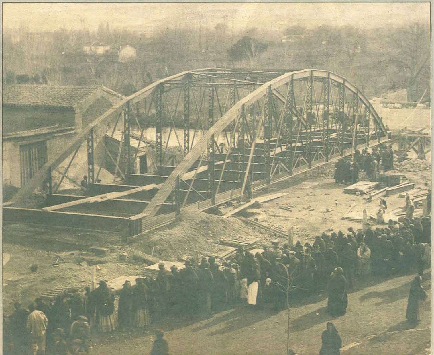
EXPECTACIÓN. La construcción del 'Puente de Hierro' levantó una gran expectación entre la sociedad palentina. Los vecinos se congregaban en la orilla del Carrión para observar los trabajos y presenciar su montaje definitivo. / COLECCIÓN FÉLIX POLLOS
