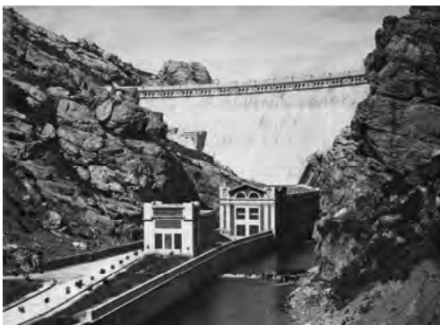
Foto 21: Vista de la presa y de la central hidroeléctrica
