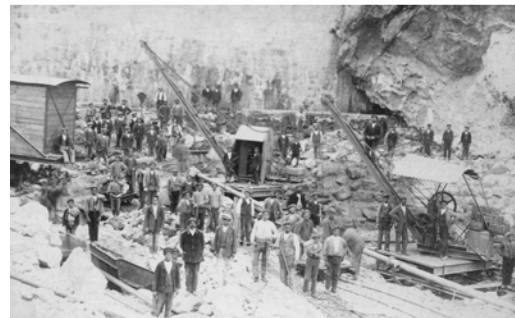
Foto 10: Excavación en la cimentación. Detalle
