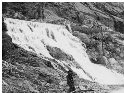
Foto 23: Aliviadero de canal hidroeléctrico
