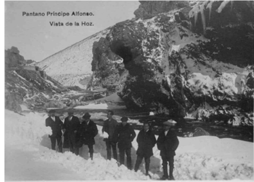
Foto 4: La cerrada una vez iniciada la excavación
