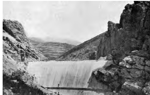
Foto 14: La presa a mitad de altura. Vista general
