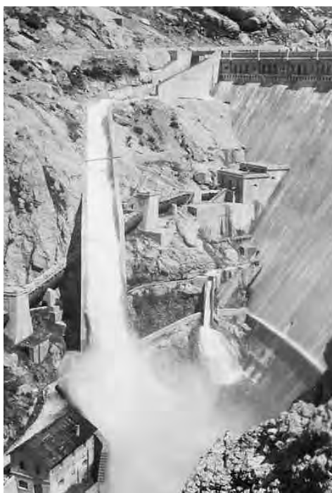
Foto 27: Aliviadero de la MD vertiendo, antes de la ampliación
