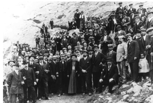
Foto 2: Colocación de la primera piedra. Año 1914
