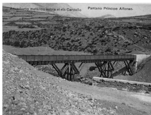
Foto 24: Acueducto metálico del canal hidroeléctrico
