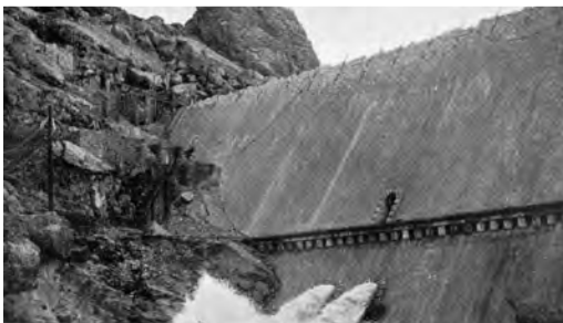
Foto 15: La presa a mitad de altura. Margen derecha
