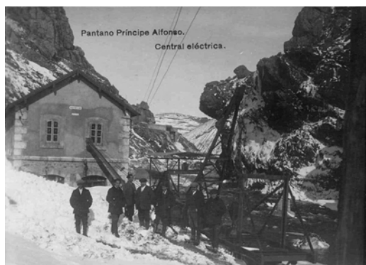
Foto 25: Central hidroeléctrica para la obra
