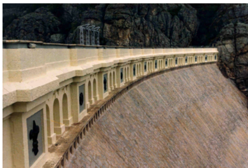
Foto 33: Coronación de la presa. Estado actual
