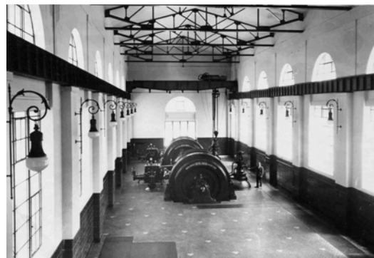
Foto 22: Interior de la central hidroeléctrica con dos grupos
