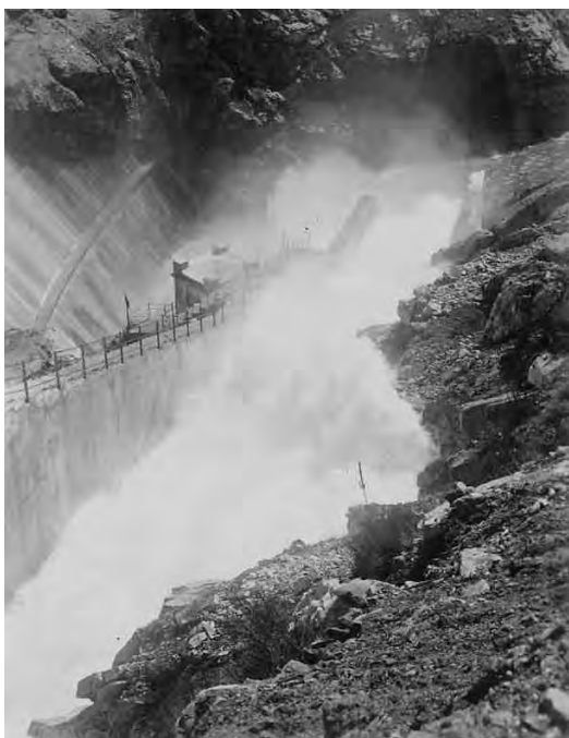
Foto 30: La misma curva, vista hacia aguas arriba
