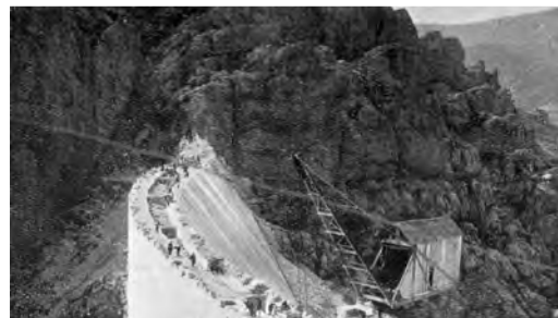
Foto 16: La presa cerca de la coronación
