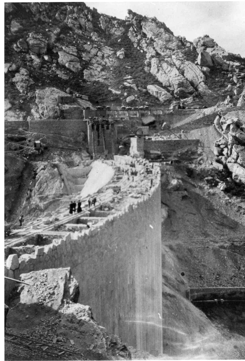
Foto 18: La presa cerca de coronación desde margen izquierda
