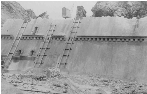
Foto 13: Acceso a cámara y salida de desagües de fondo. Año 1920
