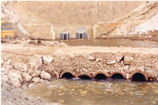
Foto 35: Nuevas rejillas en desagües de fondo, detrás de la atagüa primitiva demolida parcialmente
