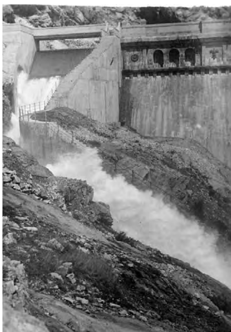
Foto 29: Curva en planta en el aliviadero de la MD, antes e la ampliación
