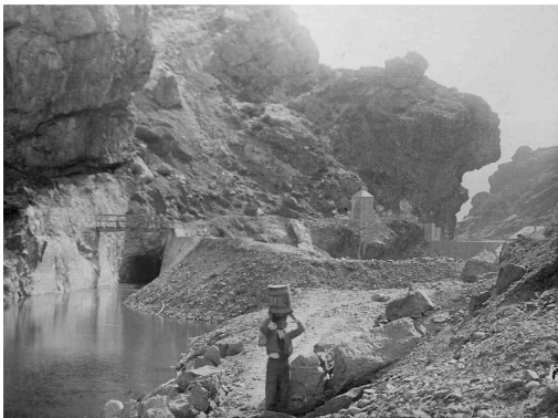
Foto 5: Túnel de desvío, preataguía y ataguía
