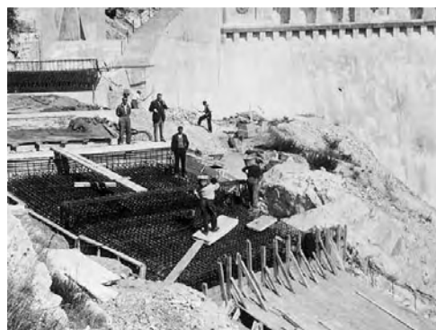
Foto 32: Obra de ampliación del aliviadero de la MD
