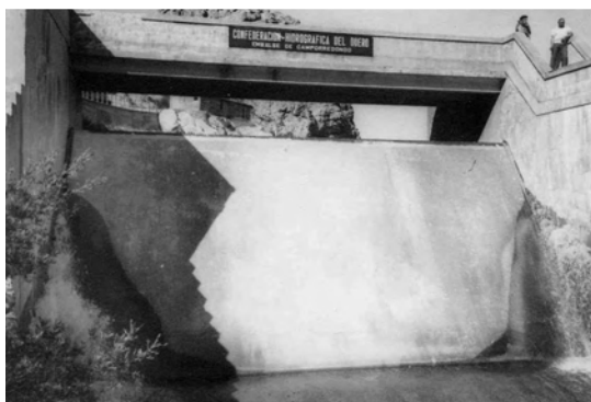
Foto 31: Compuerta de sector en aliviadero de la MD
