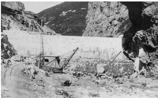
Foto 9: Excavación en la cimentación. Se distingue la ataguía de lo que es excavación en roca
