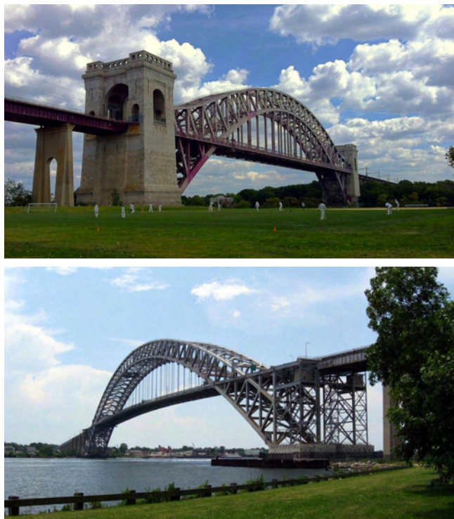
Figura 7. Dos modos de resolver las pilas en puentes no muy distantes entre sí: el Hell Gate (Gustav Lindenthal, 1916) y el puente de Bayona (Othmar Ammann, Allston Dana, Cass Gilbert, 1931).
