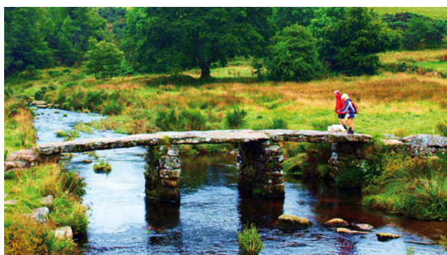
Figura 3. «El más moderno y antiguo problema de la ingeniería civil»: Clapper Bridge, en Postbridge (Reino Unido) 1 .
