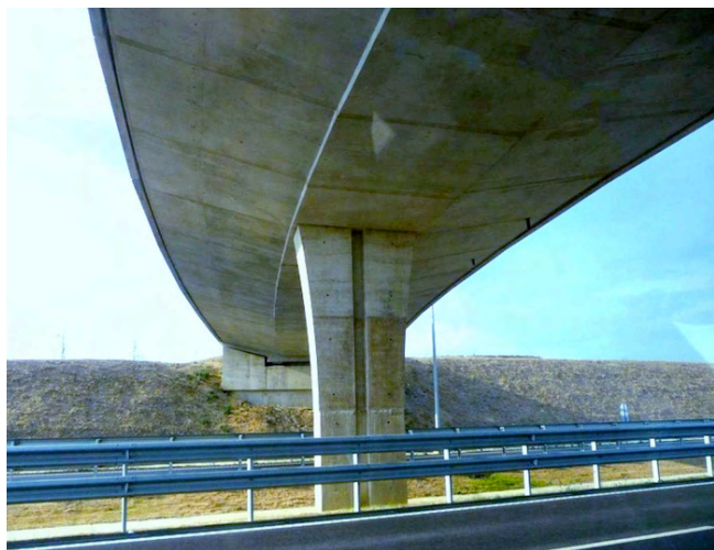
Figura 4. Uno de los pasos superiores en la autopista AP-1, Vitoria-Eibar.
