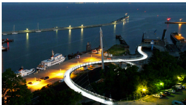
Figura 6. Pasarela de Sassnitz.
