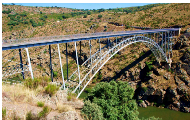
Figura 1. Puente de Pino, en Zamora.
