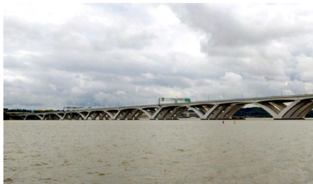
Figura 5. Puente Wilson, en Washington.
