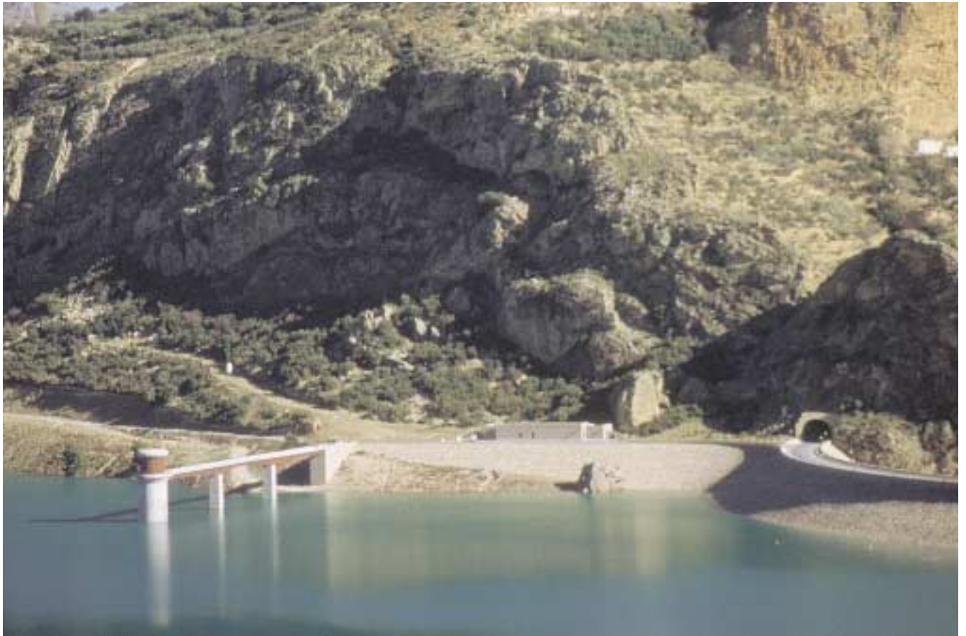
Fig. 13. Presa del Portillo. Paramento de aguas arriba.
