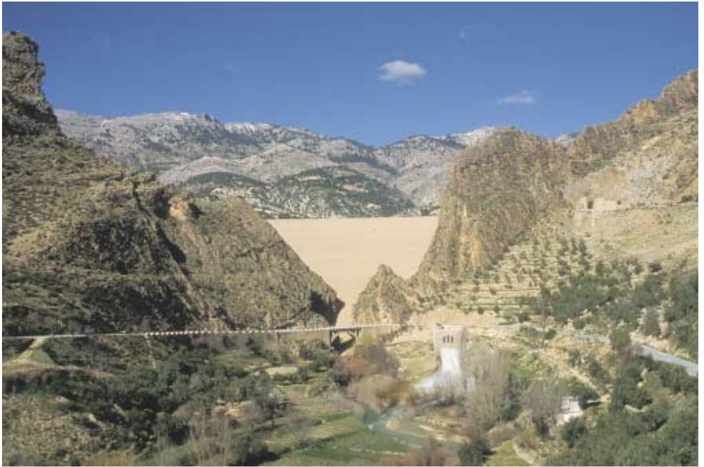
Fig. 1. Presa del Portillo desde aguas abajo.
