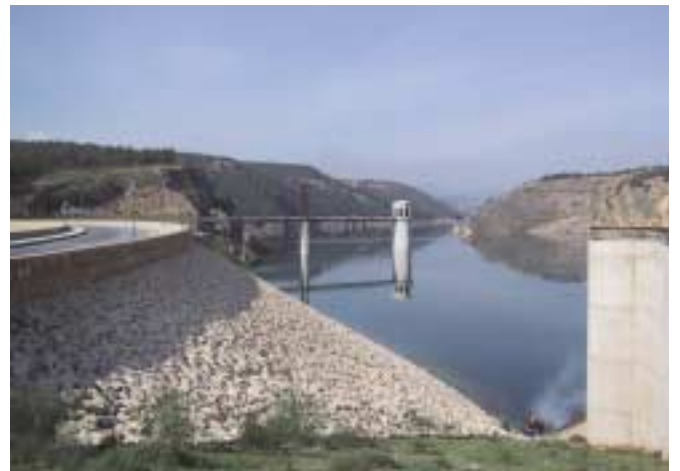
Fig. 3. Presa Francisco Abellán. Presa y torre.
