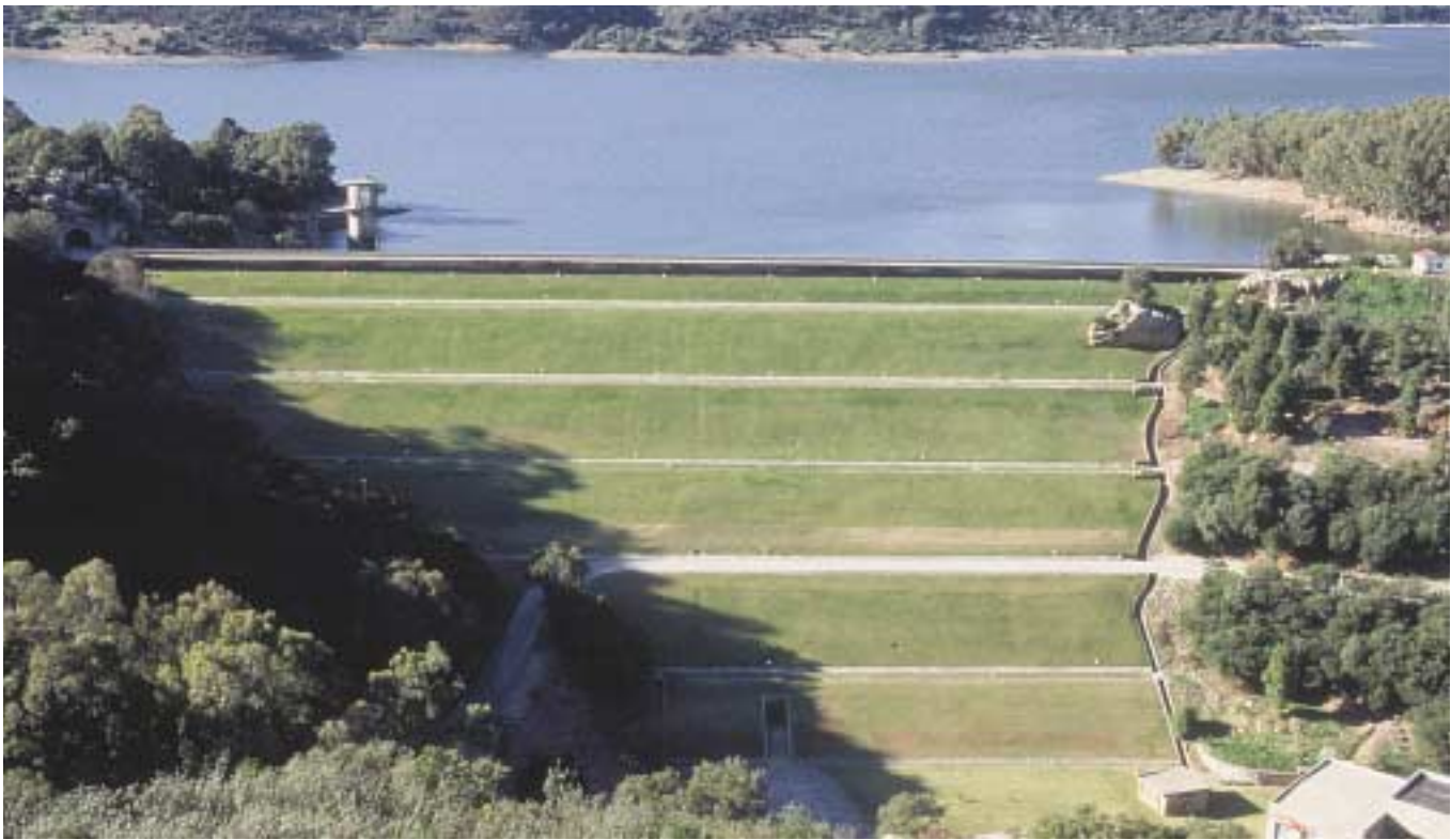
Fig. 8. Presa de Guadarranque.
