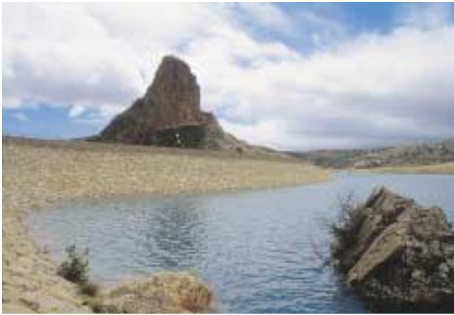
Fig. 4. Presa del Portillo desde aguas arriba.
