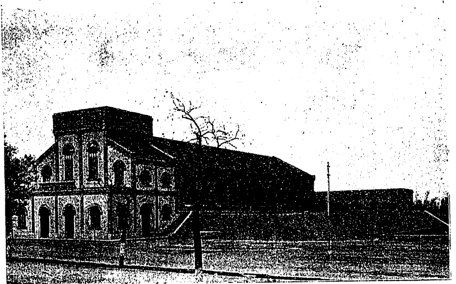
Vista de la estación depuradora
