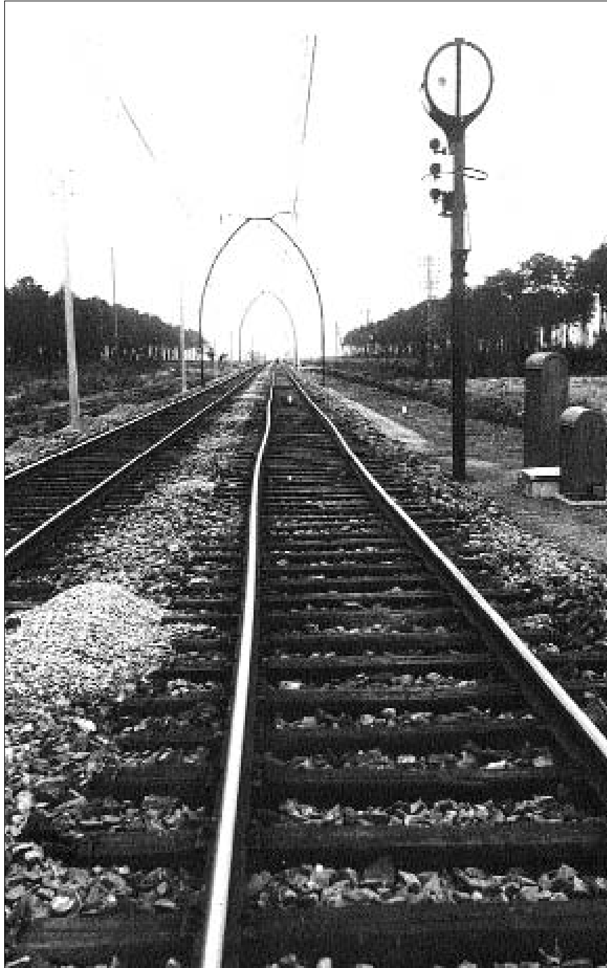
Fig. 6. Estado de las vías después de circular a 331 km/h (1955).
