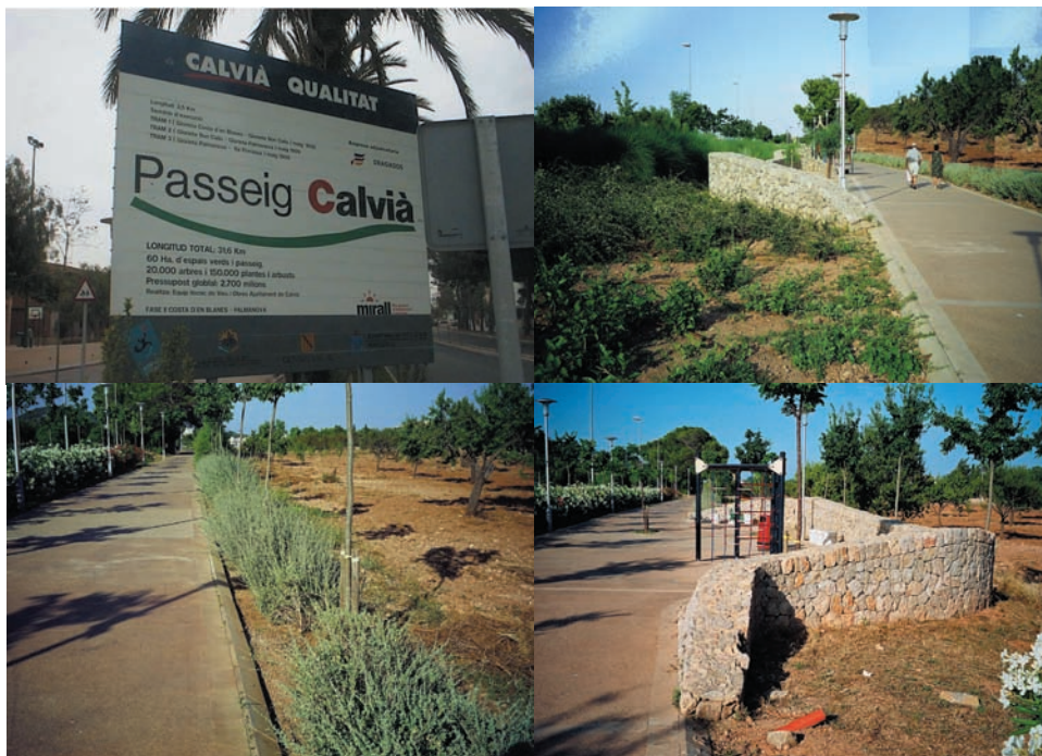
Tramos contruidos del Paseo Calvià, 32 km de paseo y 60 Ha de zonas verdes.
