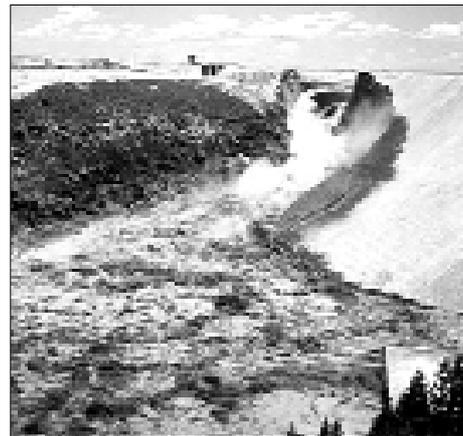
Figura 4.7. Secuencia de la rotura de Teton a partir de las 10.30 a.m. aproximadamente. La rotura violenta de la presa (quinta fotografía) se produce a las 11.57 a.m.
