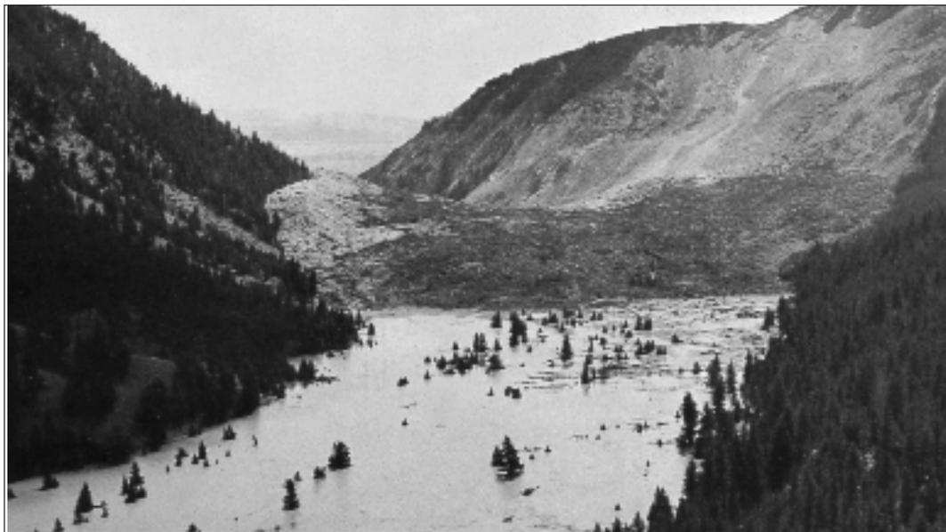
Figura 1.5. Corrimiento sobre el río Madison, E.E.U.U. El agua del río comienza a embalsarse a causa de la presa creada por el deslizamiento, (Shelton, 1966).
