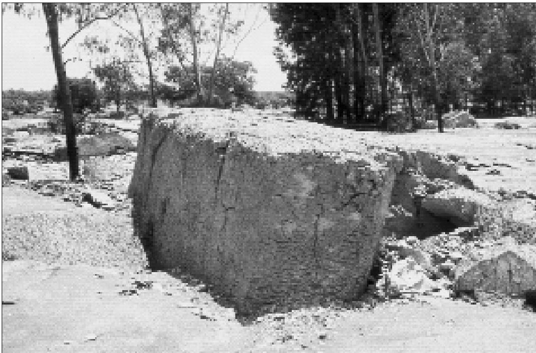
Figura 6.5. Bloque de arcilla del Guadalquivir arrastrado por la corriente de estériles fluidificados (en la base del bloque) tras la rotura de la balsa.
