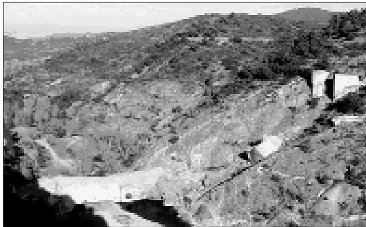
Figura 2.19. Relación de la estructura de Malpasset con la dirección de foliación del gneiss de cimentación (Londe, 1987).
