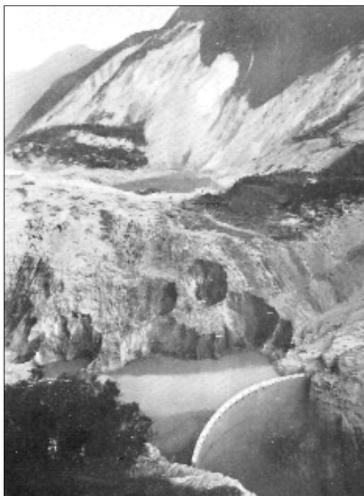
Figura 2.2. El pie del deslizamiento de Vaiont inmediatamente aguas arriba de la presa. (Valdés y Díaz Caneja, 1964). Al pie del escarpe se observa un lago residual creado por el movimiento.
