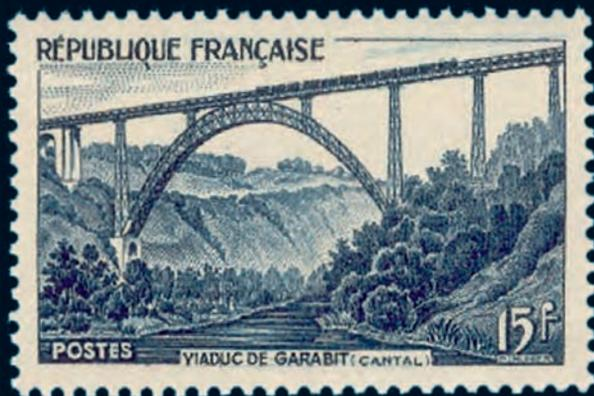
El puente de Garabit, obra de Eiffel y Compañía, se completó en 1884, aunque no entró en servicio hasta 1888. El tablero de 565 metros de longitud cruza el río Truyère, originalmente a una altura de 122 metros, que luego se acortó a 95 metros por la sobreelevación del agua causada por la construcción de la presa de Grandval. El puente se inspira claramente en el de María Pía, sobre el Duero en Portugal, terminado en 1877 y también obra de la empresa de Eiffel.
