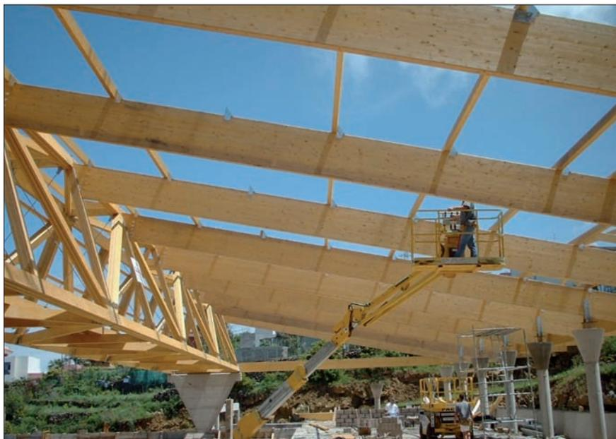
Figura 1.11 Piscina de la Matanza en Tenerife. Cercha lucernario tridimensional de 42 m construida con madera microlaminada kerto soportando vigas de madera laminada de 20 m.
