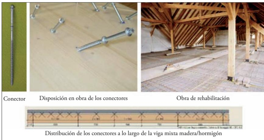
Figura 5.15 Conectores madera/hormigón.
