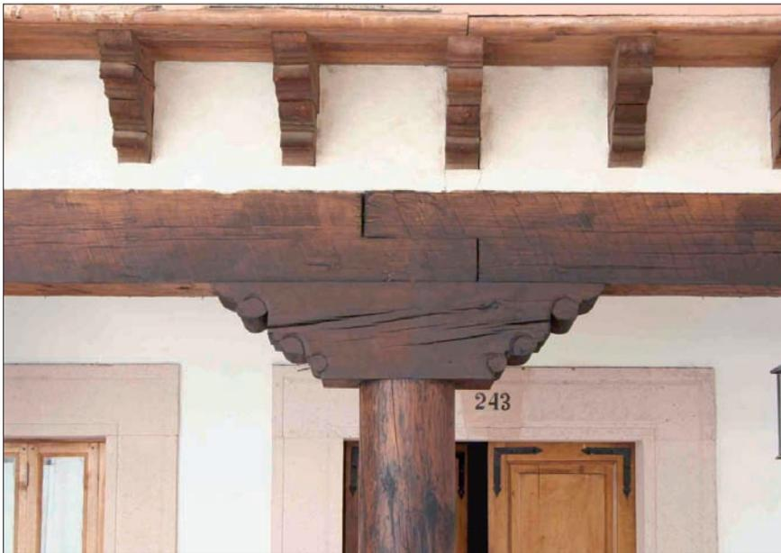
Figura 4.1 Fotografía de unión tradicional viga / soporte.
