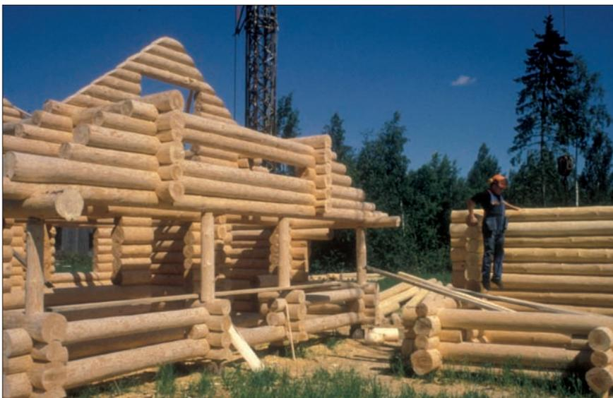
Figura 1.5 Construcción de madera enteriza en rollo.
