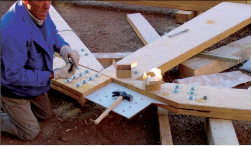
Figura 2.11 Se intercalan placas de acero para mejorar el rendimiento de la unión.
