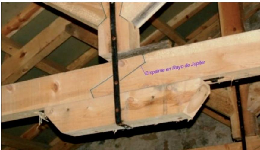
Figura 4.4 Empalme en rayo de Júpiter del tirante de una cercha.
