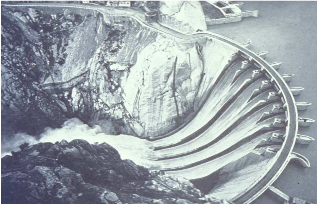
Fotografía 12. Presa de Aldeadávila
