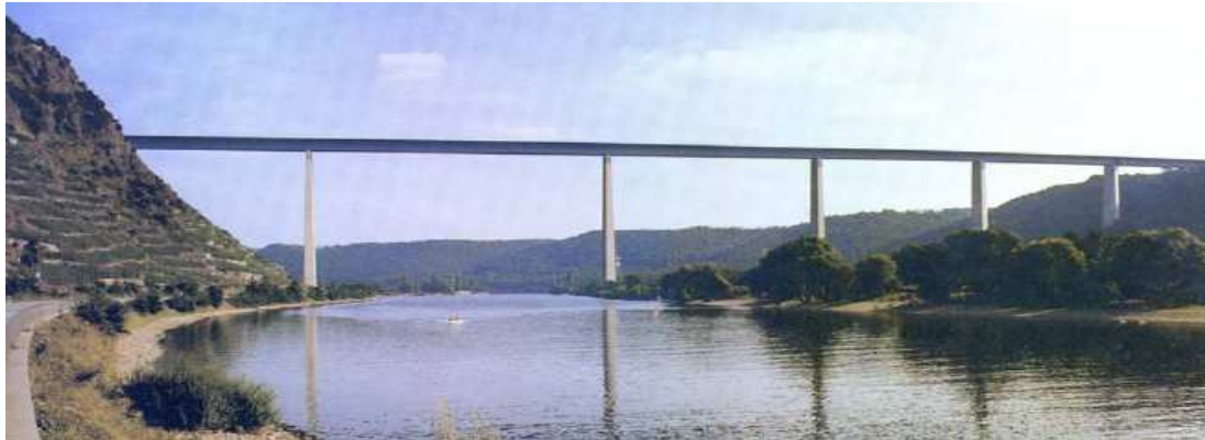
Fotografía 16. Puente de Winnigen
