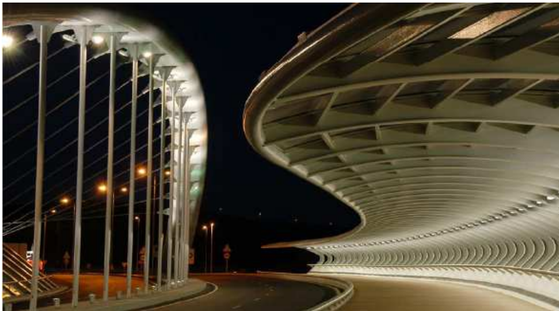
Fotografía 15. Puente del río Galindo
