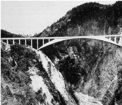
Fotografía 13. Puente de Salgina Tobel
