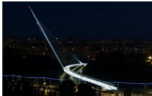
Fotografía 14. Pasarela Expo 2008 (Zaragoza)
