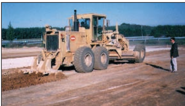
Fig. 10. Escarificación del suelo
