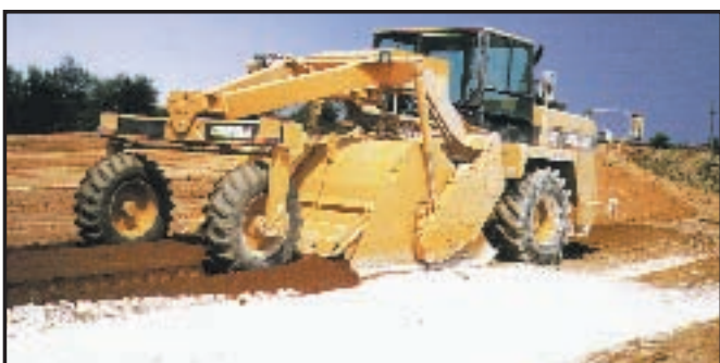
Fig. 9 - Mezclado del suelo y la cal.
