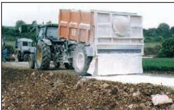
Fig. 12. Extendido de la cal.
