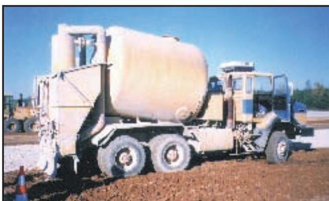
Fig. 8 - Extendido de la cal.
