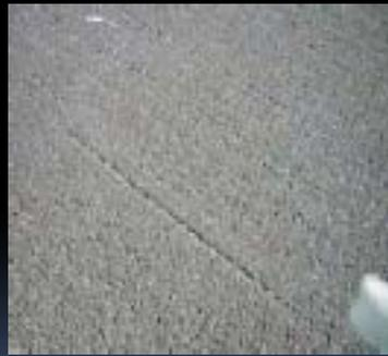
**Ranuras longitudinales:** Marcas paralelas al sentido de la extensión que alcanzan hasta el nivel inferior
