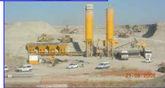
Machaqueo y cribado en obra
