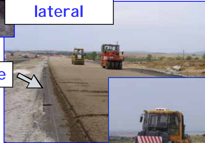
Tren de compactación
