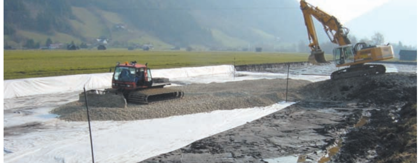
Utilización de geosintéticos en suelos colapsables (foto superior) y estabilización de suelos blandos (foto inferior).
