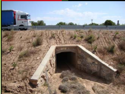
PASO Nº 16 Marco Prefabricado CARRETERA N-232 CASTEJÓN-TUDELA. AÑO 2008
