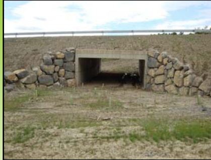
PASO Nº 6 Marco prefabricado CARRETERA NA-178 PUERTO DE ISO. AÑO 2008
