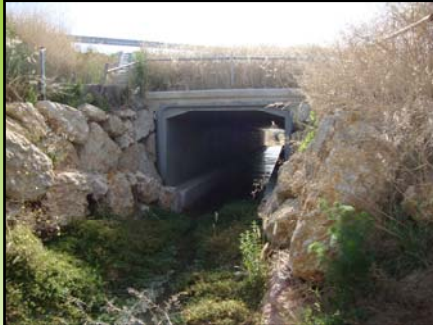
PASOS Nº 13 Nº 14 y Nº 15 PK Marcos Prefabricados CARRETERA NA-122 VARIANTE DE ALLO. AÑO 2007
