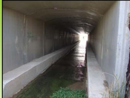
PASOS Nº 13 Nº 14 y Nº 15 PK Marcos Prefabricados CARRETERA NA-122 VARIANTE DE ALLO. AÑO 2007
