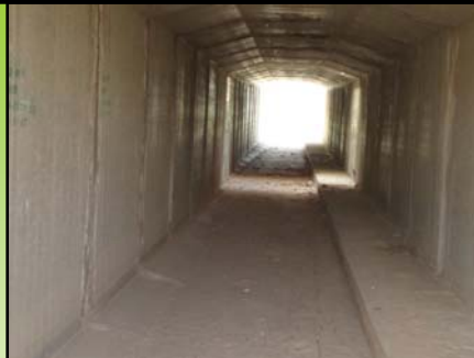
PASO Nº 16 Marco Prefabricado CARRETERA N-232 CASTEJÓN-TUDELA. AÑO 2008
