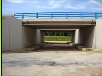
PASO Nº 10 Puente CARRETERA A-21 AUTOVIA PAMPLONA-HUESCA. AÑO 2008
