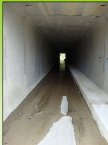
PASO Nº 7 Marco prefabricado. CARRETERA NA-178 PUERTO DE ISO. AÑO 2008
