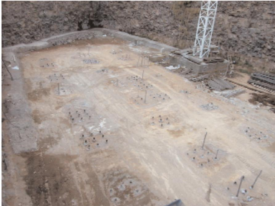
*Cimentación finalizada a falta de la construcción de los encepados*
